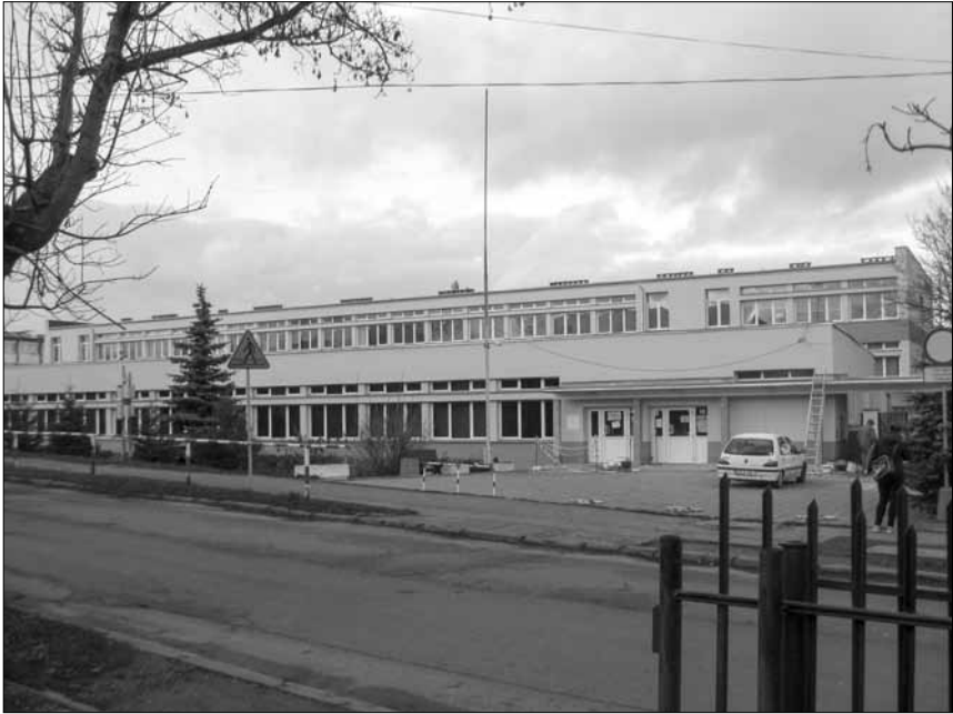
Rys. 23. Budynek Zespołu Szkół nr 5 przy ulicy Ogrodowej w Wałbrzychu Źródło: Filip Żurakowski
