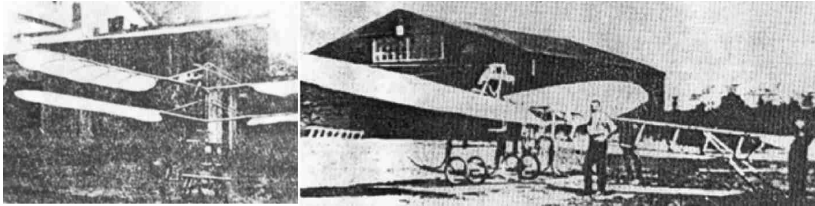
Rys. 3-34. Konstrukcje lotnicze Czesława Tańskiego: a - śrubowiec (1908), b - samolot łątka (1911) (GLASS 1984)
