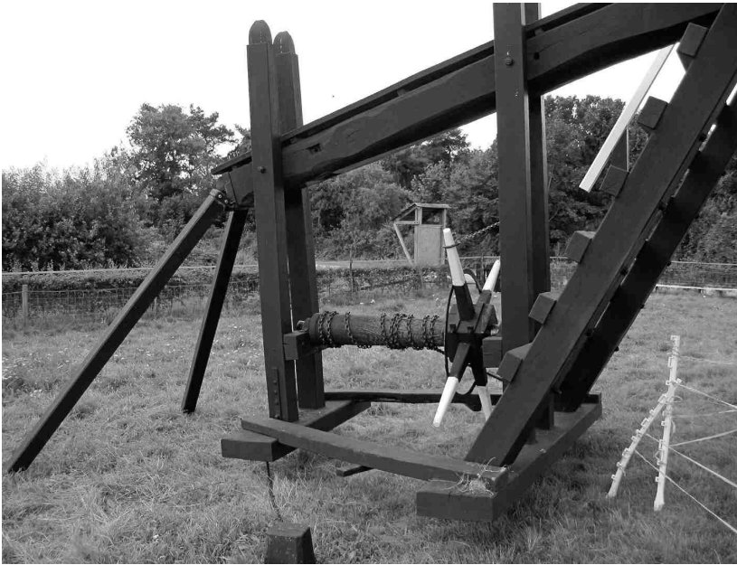
Rys. 3-60. Kołowrót do nastawiania wiatraka (młyn w Ede w Holandii; zbudowany na przełomie XVI i XVII wieku, stan obecny)
