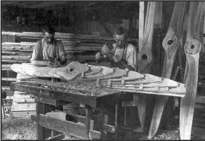
Rys. 3-39. Proces produkcji śmigła (przed 1915 rokiem) (WOODENPROPELLER 2007)
