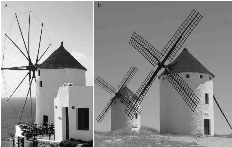
Rys. 3-57. Wieżyczkowe wiatraki śródziemnomorskie (stan obecny): a - z „żaglowym” śmigłem, grecka wyspa Mykonos, b - w hiszpańskim Campo de Criptana (region La Mancha)
