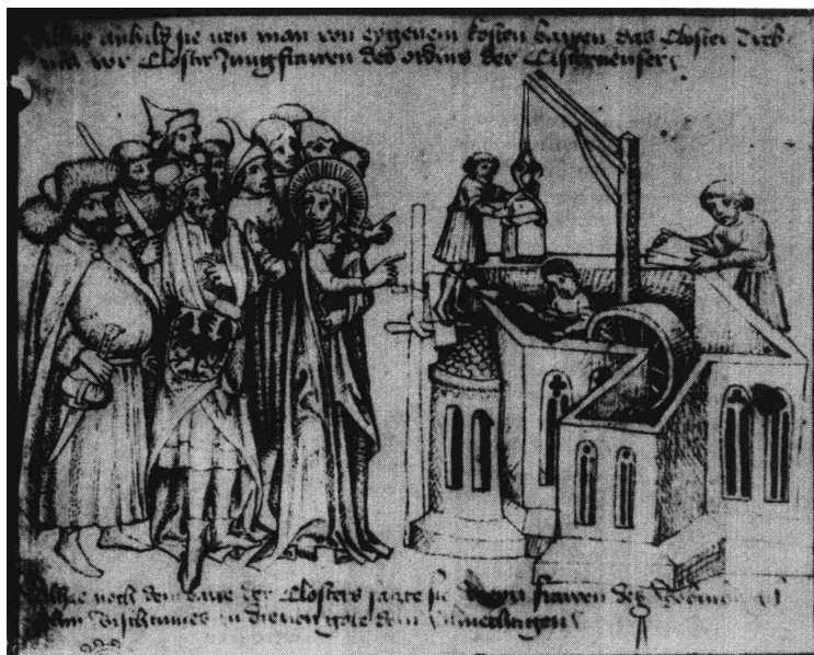
Rys. 3-21. Żuraw napędzany kołem deptakowym podczas budowy kościoła w Trzebnicy (z obrazkowej legendy o św. Jadwidze Śląskiej z 1451 roku, WIŚLICKI 1996)
