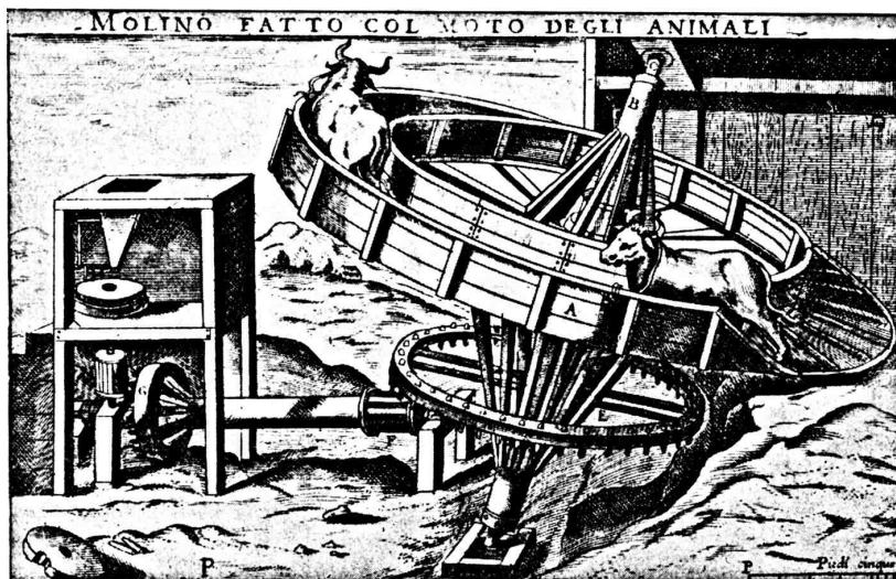
Rys. 3-75. Koło deptakowe napędzające młyn zbożowy według Vittorio Zonki (ZONCA 1607)
