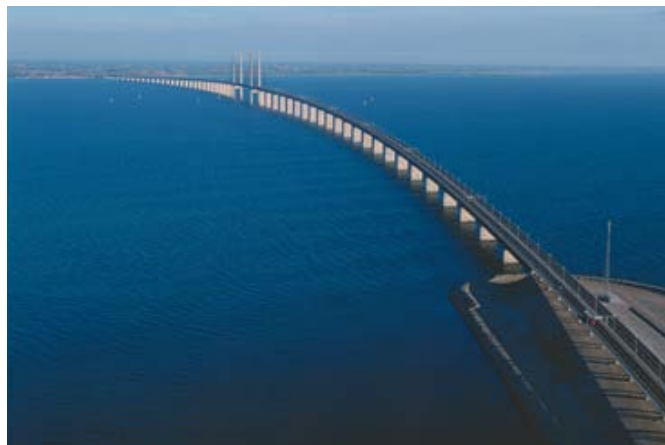
Рис. 4. Эресуннский мост. Источник: Öresundsbron, http://uk.oresundsbron.com/page/1281
