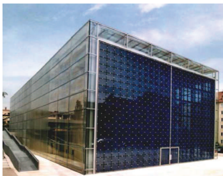
Fot. 1.5. Kościół Serca Jezusowego w Monachium – przykład elewacji „klejonej” [21]
