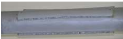
Rys. 4. Koniczne nakładki wzmocniające
