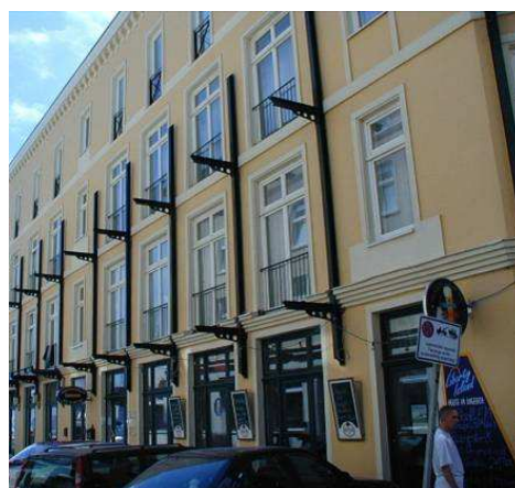
Rys. 5.6. Konstrukcje balkonów: a) samonośne, b) wspornikowe
