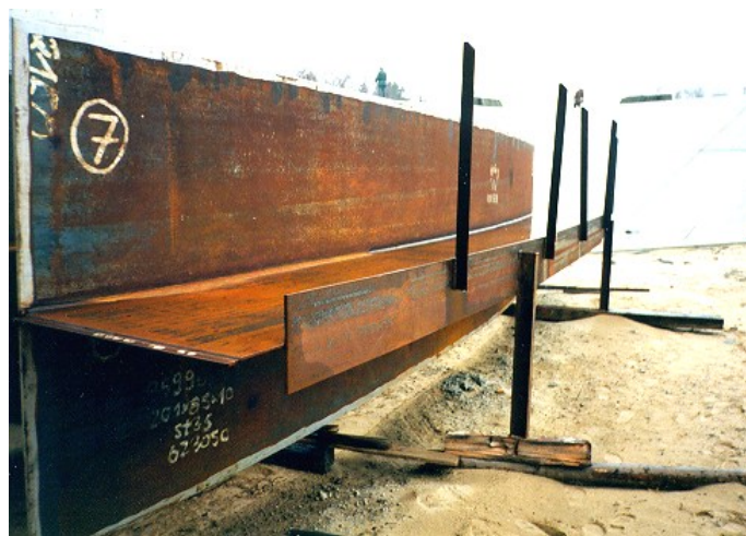
Rys. 4. 10. Prefabrykat ostatniego pierścienia płaszczu
