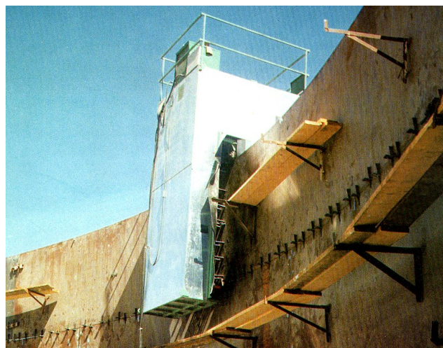
Rys. 4. 8. Automat spawalniczy
