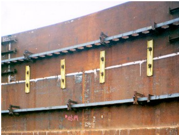
Rys. 4. 5. Usztywnienia montażowe
