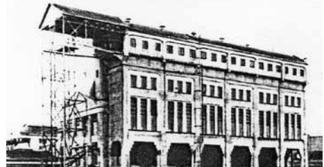
Mościce. Budynek generatorów gazowych
