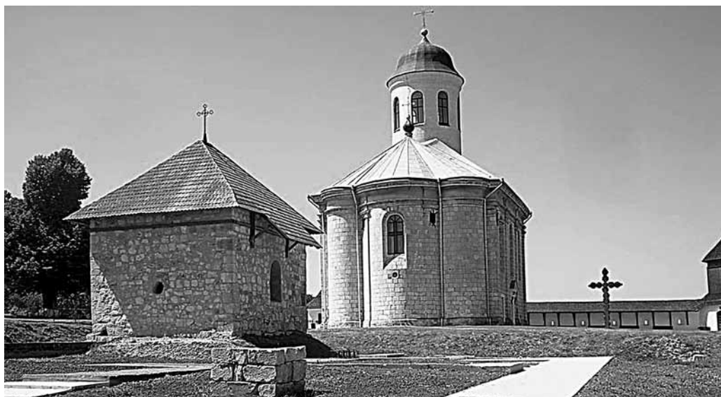
Il. 20. Halicz. Cerkiew pw. Zaśnięcia Matki Boskiej oraz odsłonięte i rekonstruowane fundamenty soboru katedralnego pw. Zaśnięcia Matki Boskiej w Kryłosie
