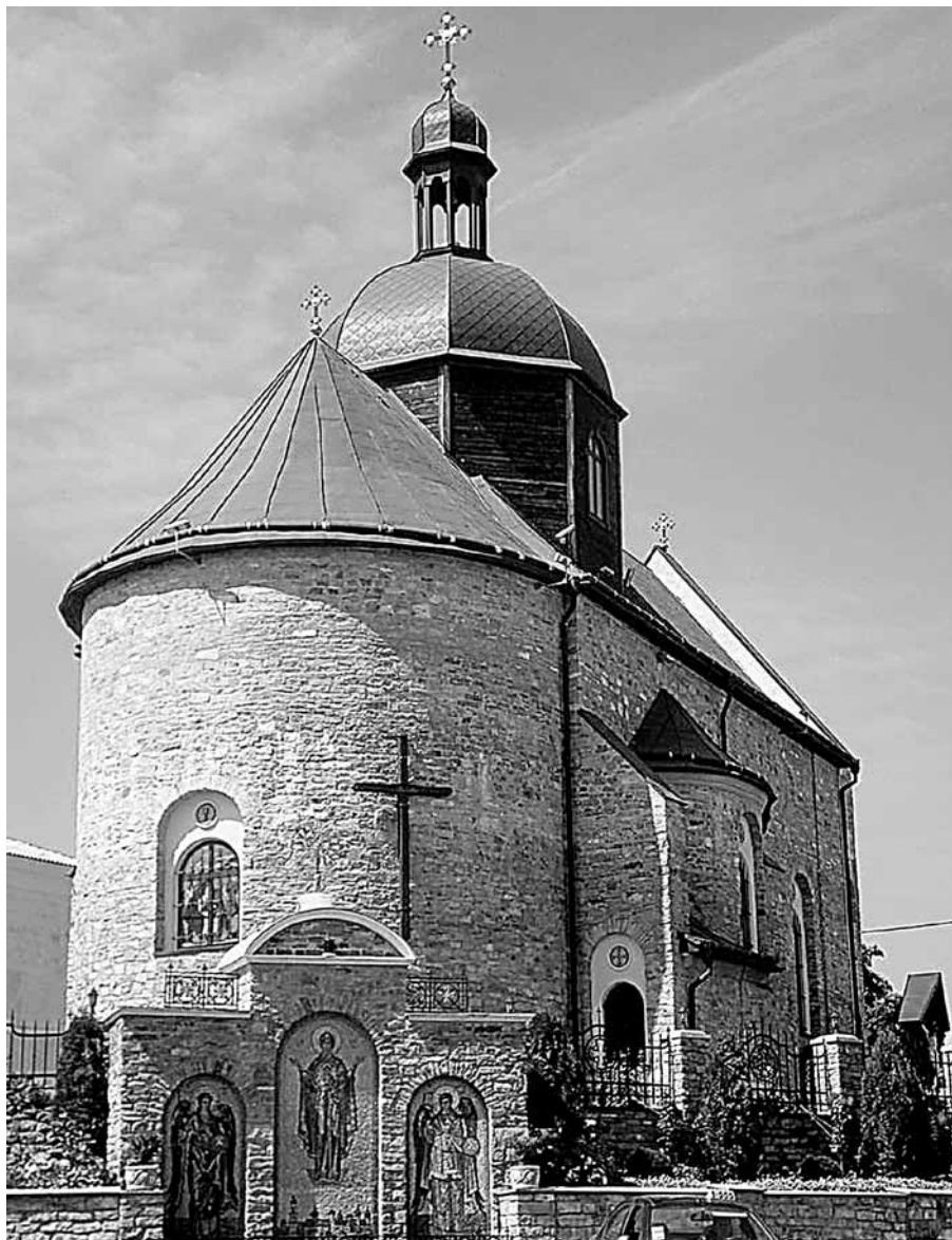
Il. 29. Kamieniec Podolski. Cerkiew pw. św. Trójcy
