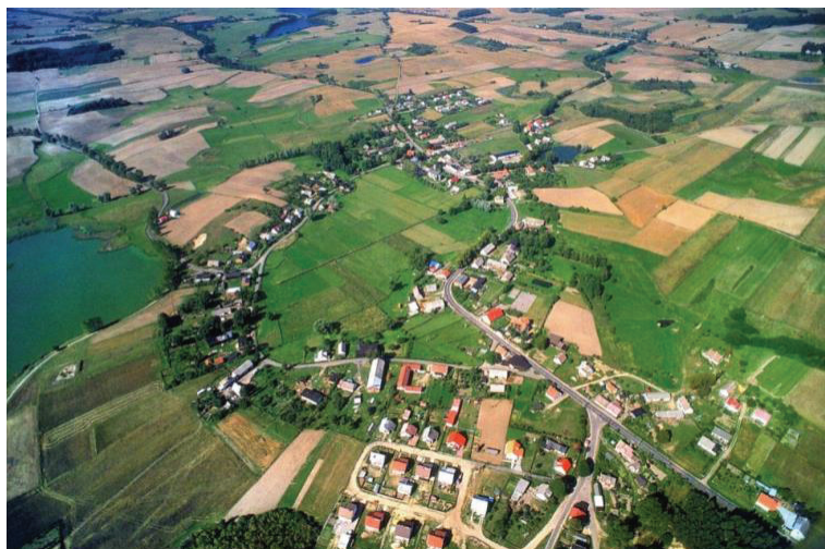
Rysunek 1. Przykład typu morfogenetycznego wsi – okolnicy z zaburzonym systemem zabudowy spowodowanym nowym budownictwem jednorodzinnym
