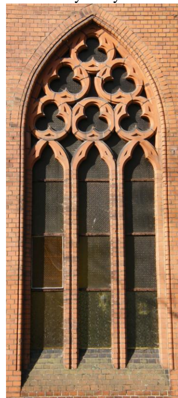
Rys. 7. Okno w elewacji wschodniej.
