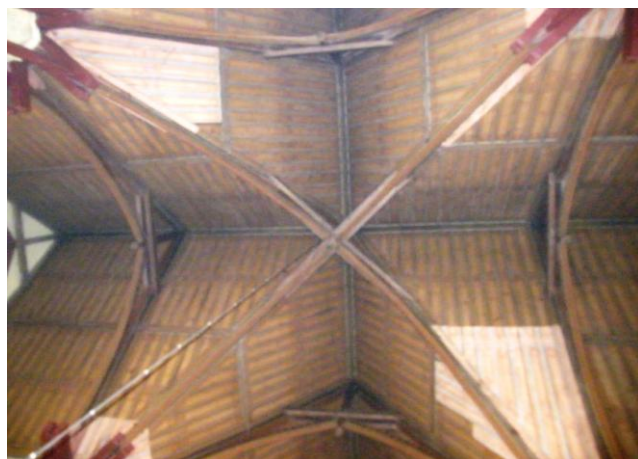
Rys. 5. Strop nad nawą.
