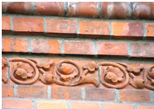
Rys. 9. Dekoracja roślinna elewacji wieży.
