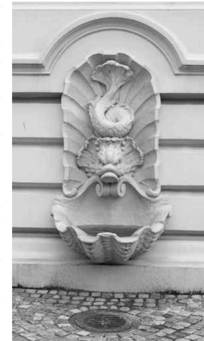
6. Zrekonstru- owany źródło przyścienny z elewacji północnej wiaduktu (fot. z archiwum autorki)
