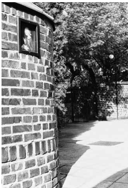
3. Kościół pw. Świętego Ducha w Tychach- Żwakowie, detal ściany. (fot. autorki)
