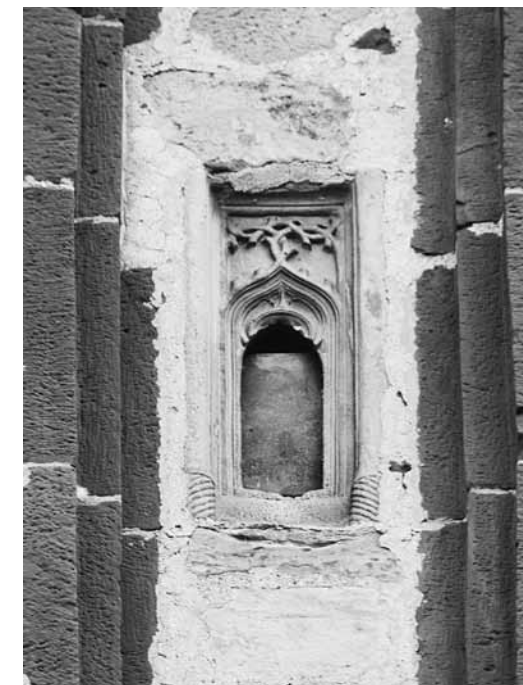
5. Północny szczyt transeptu kolegiaty, fragment z okienkiem późnogotyckim (fot. P. M. Zaniewski)
