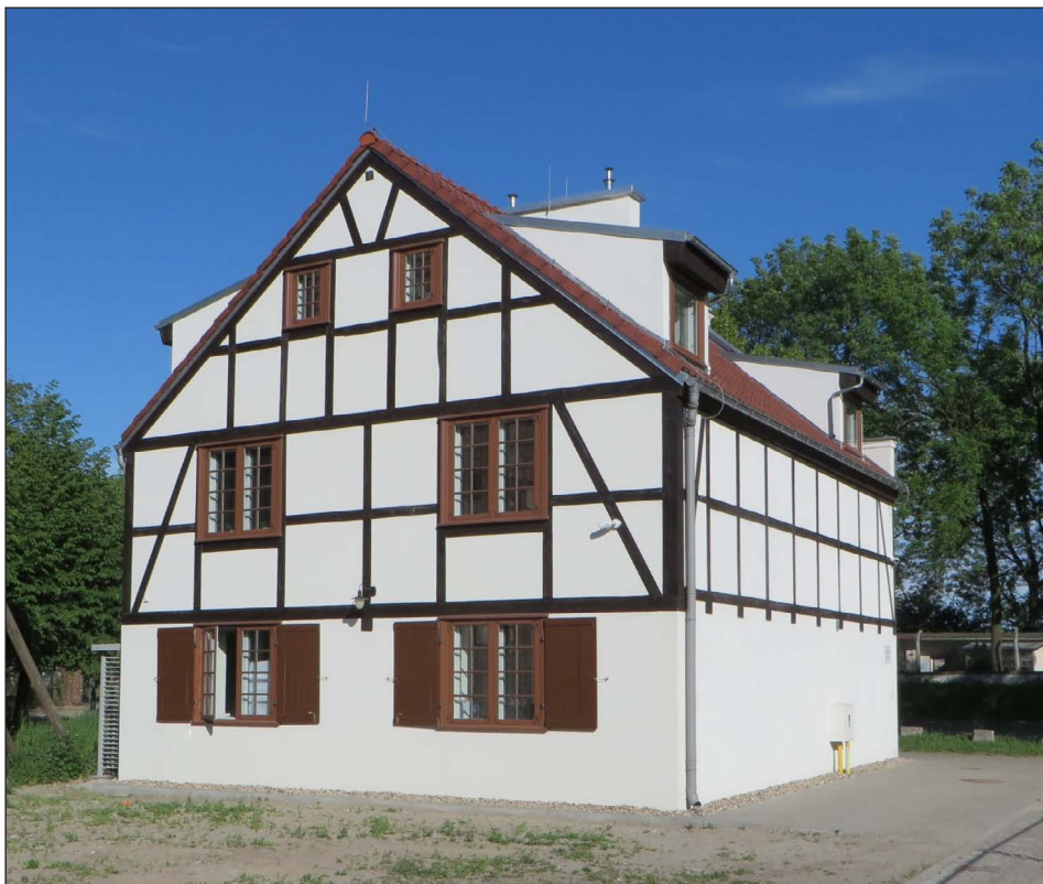
Ryc. 6.4. Odrestaurowany budynek przy ul. Reduta Wyskok 2 na terenie Dolnego Miasta
