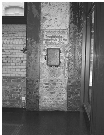
Fot. 5. Detale funkcjonalne byłej elektrowni stają się elementami dekoracyjnymi w nowej przestrzeni, wrzesień 2017 (Magdalena Abraham-Diefenbach)
