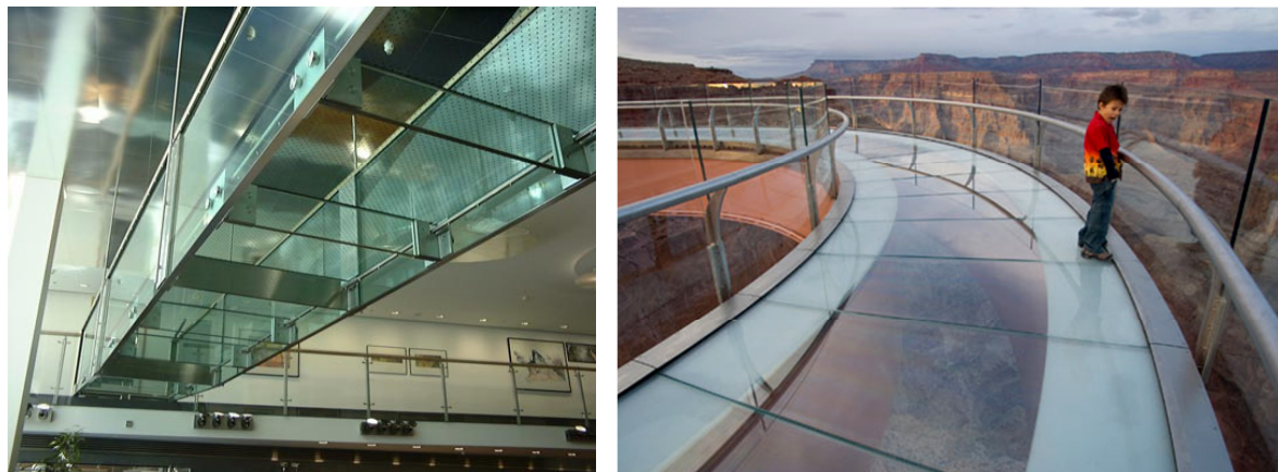
Rys. 6.19 Zastosowanie tafli szklanych jako płyty pomostu przy małej rozpiętości podłużnic (od lewej): kładka w Banku Reiffeissen, Innsbruck, Austria, Grand Canyon Skywalk, Arizona, Stany Zjednoczone [źródło: materiały informacyjne firmy Glassolutions (a, b)]
