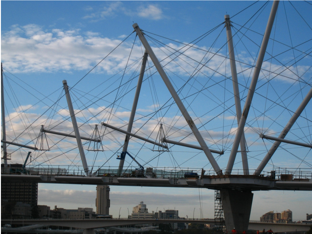
Rys. 7.20 Kładka Kurilpa: montaż zastrzałów poziomych i konstrukcji podtrzymującej zadaszenie [źródło: Flickr, autor: Margaret Donald, licencja: CC BY-NC-ND 2.0]
