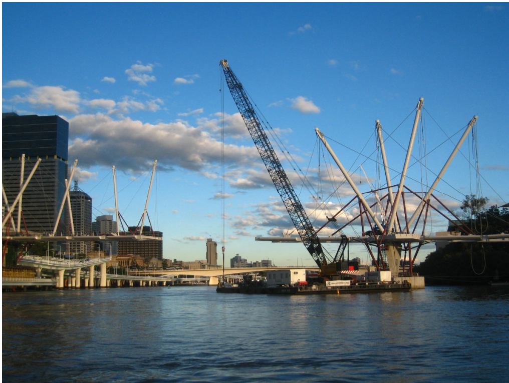
Rys. 7.19 Kładka Kurilpa: montaż słupków drugorzędnych [źródło: Flickr, autor: Margaret Donald, licencja: CC BY-NC-ND 2.0]
