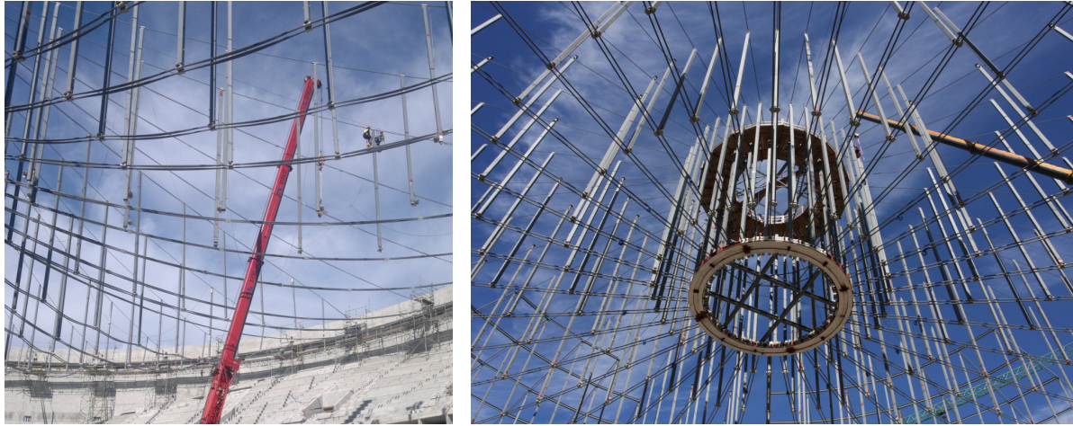
Rys. 6.21 Fazy montażu cięgnowej konstrukcji dachowej (od lewej): montaż słupków przy wstępnym naciągu kabli głównych – znaczny zwis kabli, montaż płatwi przy pełnym naciągu kabli głównych, Kraków Arena, Kraków [zdjęcia własne]
