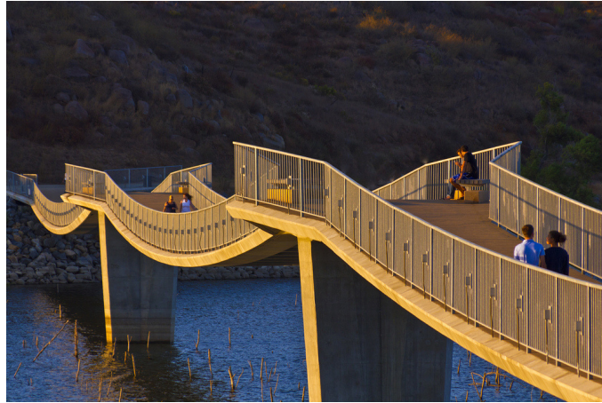
Rys. 6.29 Przykład konstrukcji wstępowej: kładka pieszo-rowerowa im. Davida Kreitzera nad Jeziorem Hodges, Escondido, Stany Zjednoczone [źródło: http://www.djgreenephotography.com , autor: Don Greene, licencja: CC BY-NC 2.0]
