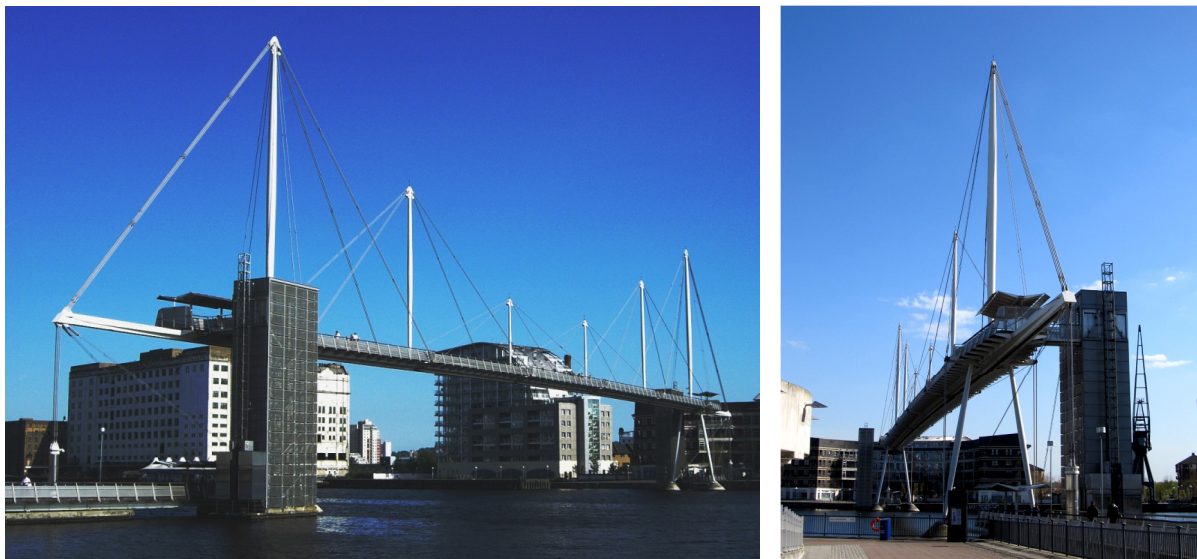
Rys. 7.3 Przykład konstrukcji quasi-tensegrity: kładka w Royal Victoria Dock, Londyn, Wielka Brytania [(od lewej) źródło: Flickr, autor: Liline, licencja: CC BY 2.0; źródło: geograph, autor: Richard Rogerson, licencja: CC BY-SA 2.0]
