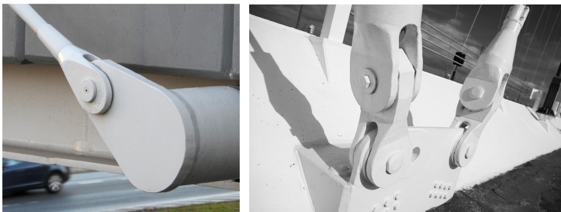
Rys. 6.10 Przykłady zastosowań połączeń widlastych w obiektach mostowych (od lewej): kładka nad ul. Żwirki i Wigury w Warszawie [zdjęcie własne], Most Severn, Walia/Anglia (granica), Wielka Brytania [źródło: Flickr, autor: Nik Stanbridge, licencja: CC BY-NC-ND 2.0]
