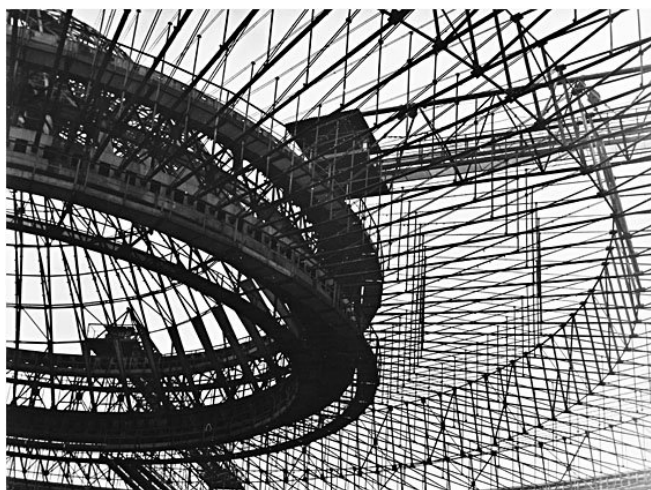
Rys. 2.14 Konstrukcja dachu „Spodka”, Katowice [źródło: http://joannanowicka.blogspot.com/ , autor: Mieczysław Migoń (dzięki uprzejmości Joanny Nowickiej)]
