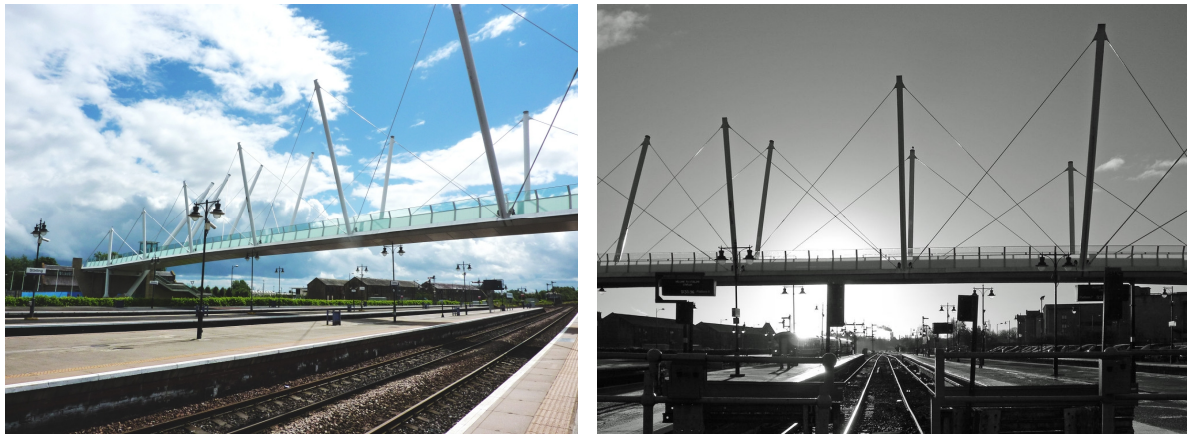
Rys. 7.2 Przykład konstrukcji quasi-tensegrity: Kładka Forthside, Stirling, Szkocja [(od lewej) źródło: Flickr, autor: SwaloPhoto, licencja: CC BY-NC 2.0; źródło: geograph, autor: Donald MacDonald, licencja: CC BY-SA 2.0]
