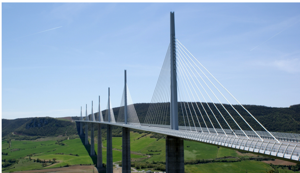
Rys. 6.6 Przykład zastosowania kabli z wiązek równoległych splotów Freyssinet HD: Wiadukt Millau, Millau, Francja [źródło: Flickr, autor: TijsB, licencja: CC BY-SA 2.0]
