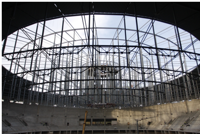
Rys. 2.12 Konstrukcja dachu Kraków Areny, Kraków [zdjęcie własne]
