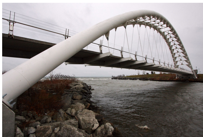
Rys. 6.18 Przykład oparcia pomostu na podwieszonych poprzecznicach: Kładka Łukowa Humber Bay, Toronto, Kanada [źródło: Wikimedia Commons, autor: Tudor Costache, licencja: CC BY-SA 3.0]
