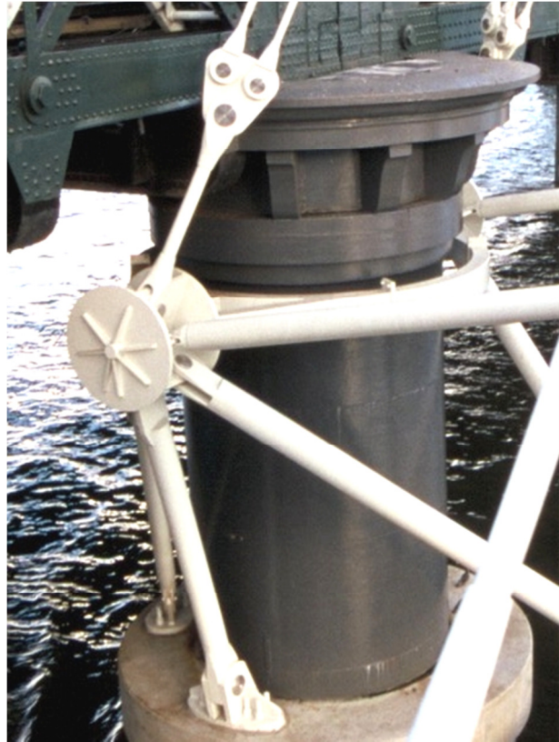
Rys. 6.14 Przykłady połączenia wielu elementów w węzle (od lewej): Kładka Hungerford, Londyn, Wielka Brytania [źródło: Flickr, autor: Bruno Girin, licencja: CC BY-SA 2.0], Budynek Królowej Wiktorii, Sydney, Australia [źródło: Deviantart, autor: Michael Domaradzki, licencja: CC BY-NC-SA 3.0]
