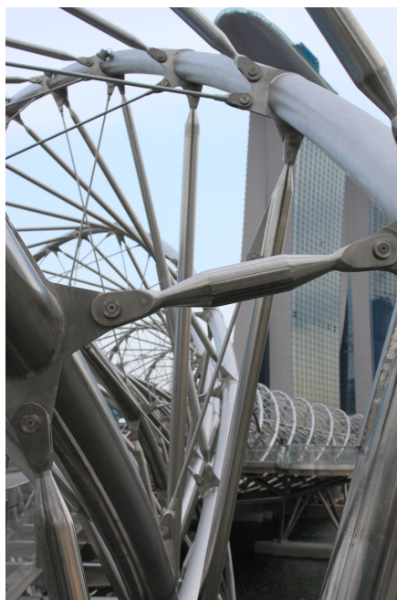
Rys. 6.12 Przykład zastosowania połączeń widlastych elementów ściskanych w obiekcie mostowym: Kładka Helix, Marina Bay, Singapur [źródło: Flickr, autor: hj_west, licencja: CC BY-SA 2.0]
