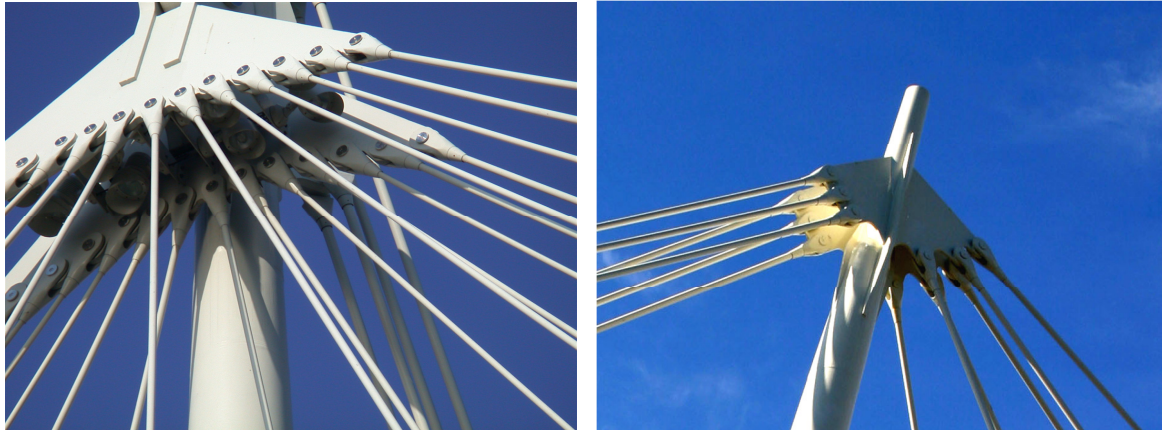
Rys. 6.13 Przykłady połączenia wielu elementów w węzle pylonu (od lewej): Kładka Hungerford, Londyn, Wielka Brytania [źródło: Flickr, autor: Andy Schultz, licencja: CC BY-NC-SA 2.0], Kładka Uniwersytetu Nortumbrii, Newcastle, Wielka Brytania [źródło: Flickr, autor: Phil Thirkell, licencja: CC BY-NC 2.0]
