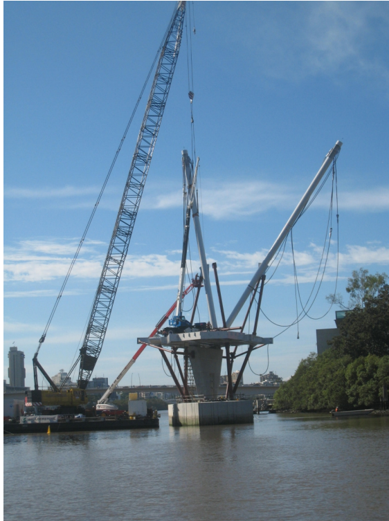
Rys. 7.18 Kładka Kurilpa: montaż głównych słupków [źródło: Flickr, autor: Margaret Donald, licencja: CC BY-NC-ND 2.0]
