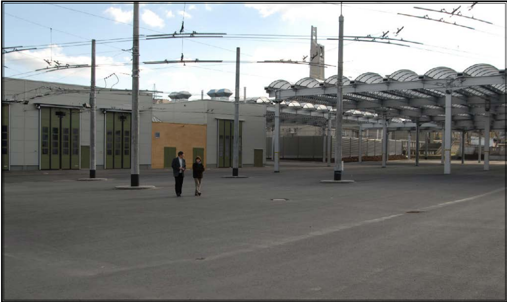
Ryc. 5.9. Zajezdnia trolejbusowa w Gdyni – widok na zadaszony plac postojowy oraz hale warsztatowe i lakiernię.
