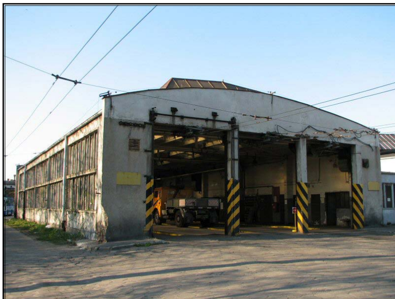
Ryc. 3.2. Jedna z hal warsztatowych zajezdni trolejbusowej w Gdyni Redłowie na początku XXI wieku.
