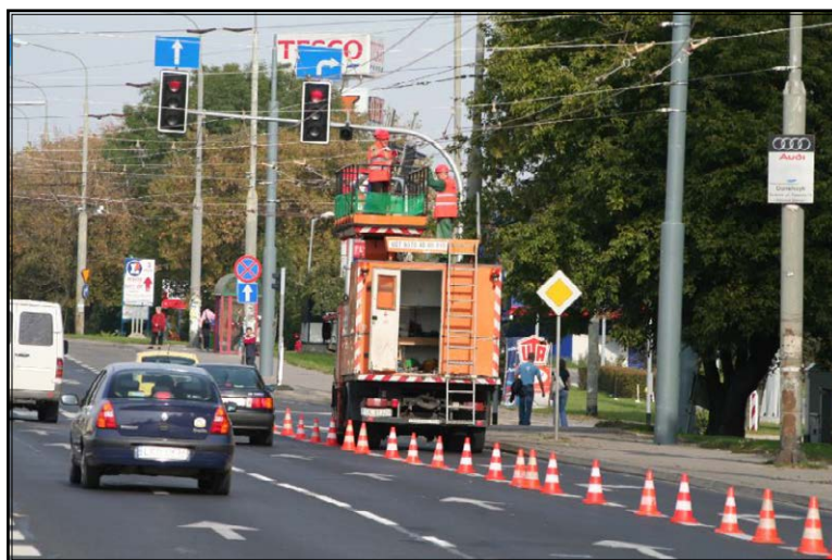
Ryc. 4.13. Budowa sieci trakcyjnej na skrzyżowaniu ulic Roztocze i al. Kraśnickiej, 23.09.2007 r. Autor: Marcin Połom.
