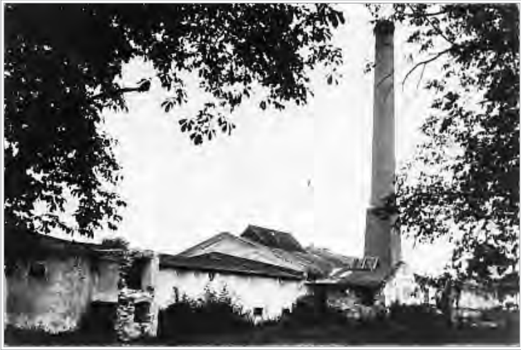
10. Ruiny cukrowni w Silniczce
