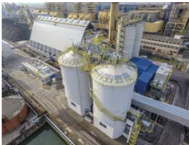
Rysunek 10.4. Blok energetyczny K-1 Elektrociepłowni Siekierki w Warszawie
