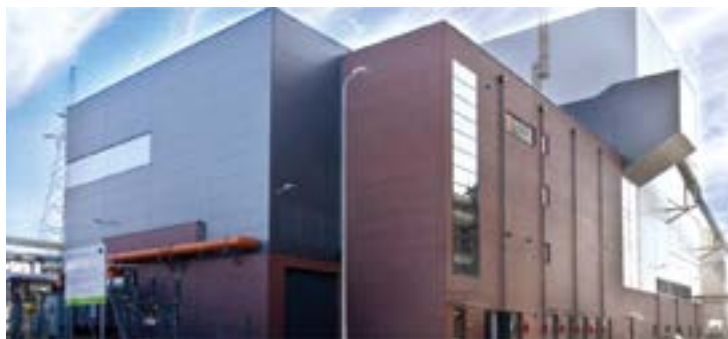
Rysunek 10.3. Blok energetyczny na biomasę spółki Energa Kogeneracja w Elblągu
