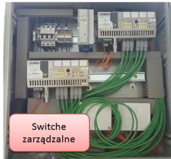
Rysunek 1.5: Switchce zarządalne („managed”) sieci wysokiego poziomu.
