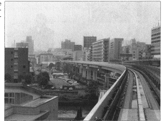
Trasa kolejki Yurikamome na linii Shimbashi–Odai-ba (sztuczne nabrzeże Zatoki Tokijskiej)
