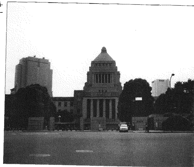
Siedziba parlamentu japońskiego (budynek z 1936 r.) – Nagatachō, Tokio
