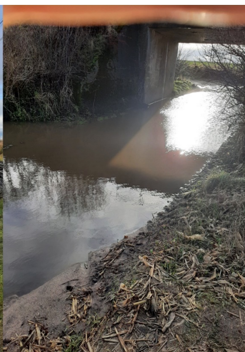
Rys. 9. Przejazd pod wiaduktem do przystanku kolejowego
