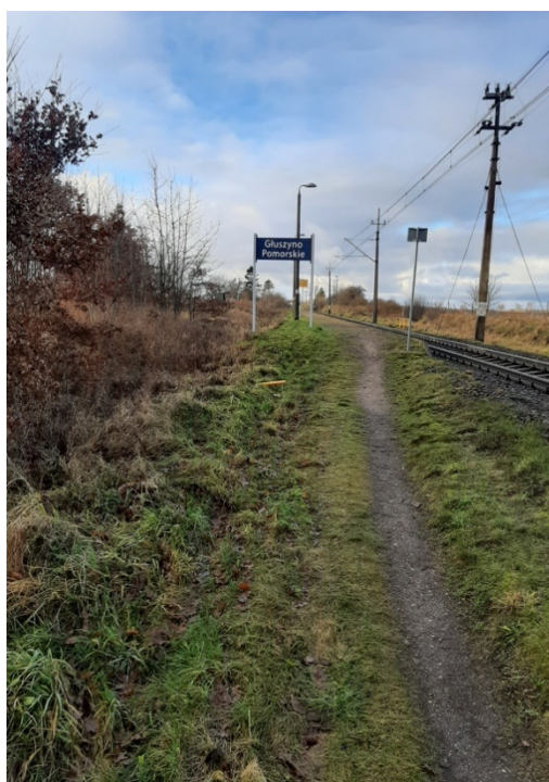
Rys. 8. Widok przystanku kolejowego
