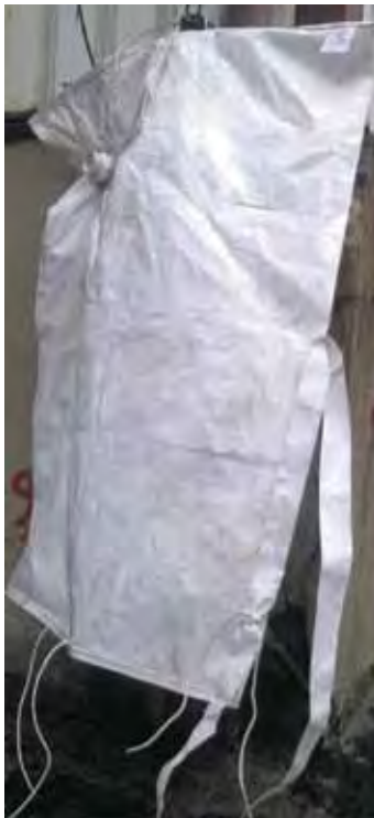
Rys. 5. Rękaw używany do wykonania wykładki mechanicznej i wypełnienia przestrzeni międzyodrzwiowej. Fig. 5. Lining with inserted hose for mechanical filling and filling of the double timber space
