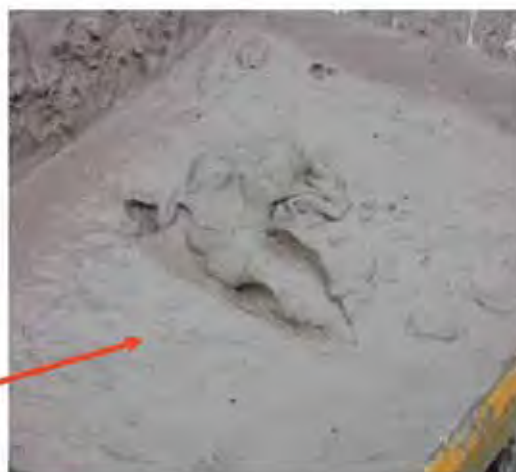
Rys. 10. Zagęszczona płuczka bentonitowa po zakończeniu mieszania Fig. 10. Condensed bentonite mud after the process of mixing
