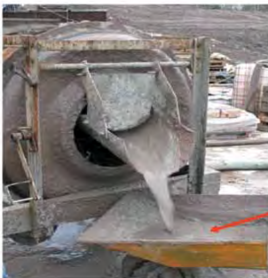
Rys. 9. Mechaniczne mieszanie płuczki z dodatkiem kompozycji środka wiążącego Fig. 9. Mechanical mixing of drilling mud with binding agent
