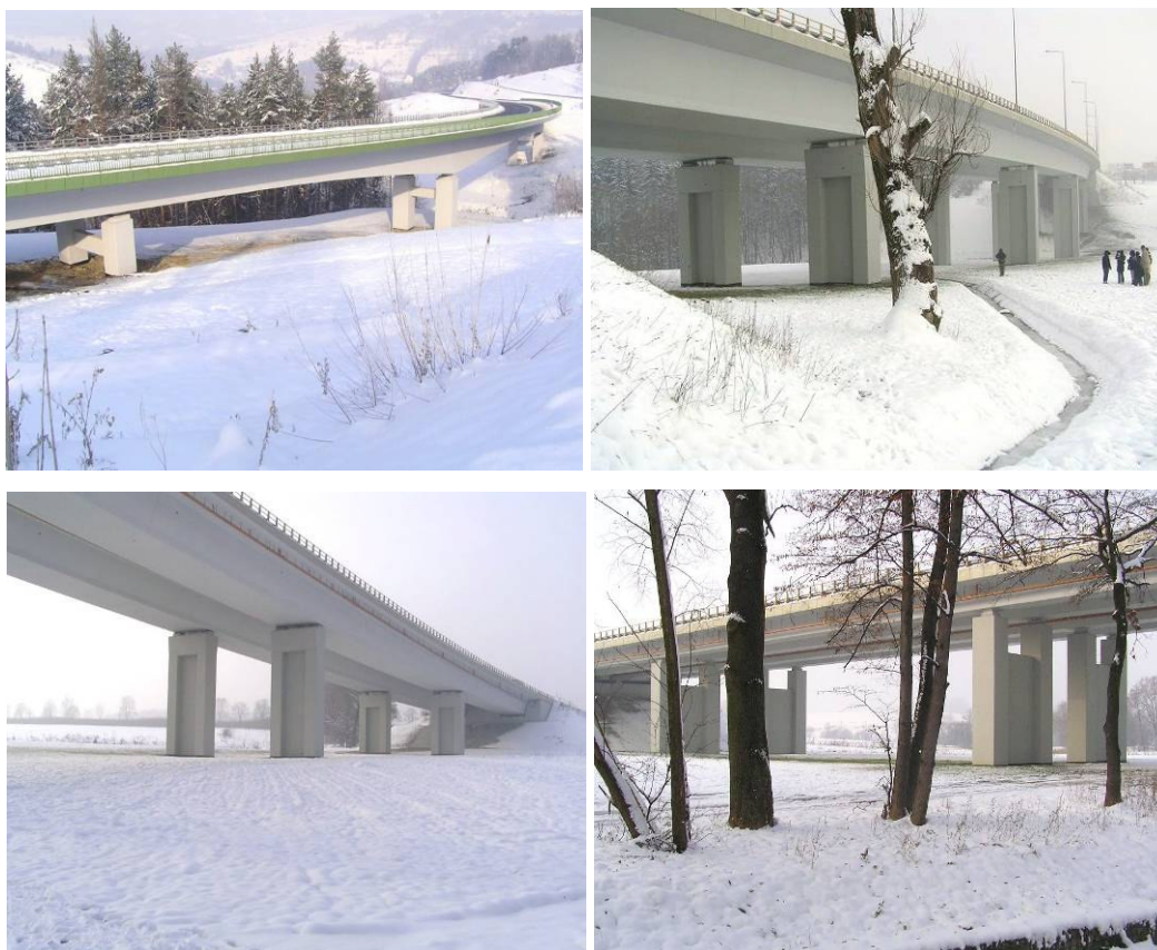
Fot. 6, 7, 8 i 9 Estakady w rejonie Bielska Białej (okolice Beskidu Śląskiego) Widoczne jest duże prześwietlenie obszaru pod estakadą, co sprawia, iż zwierzęta chętnie korzystają z takich przejść (źródło: fotografie autora).
