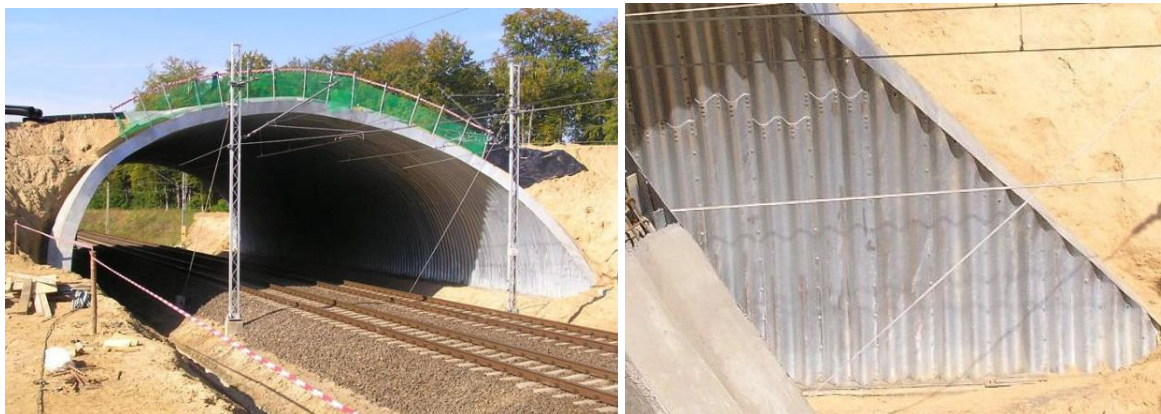
Fot. 4 i 5 Przejście górne nad linią kolejową E20 (odcinek Rzepin – Kunowice) w trakcie budowy. Konstrukcja z blachy falistej, coraz częściej wykorzystywana przy budowie przejść (również w drogownictwie). Na drugim zdjęciu widoczne elementy konstrukcyjne skręcane przy pomocy śrub (źródło: fotografie autora).
