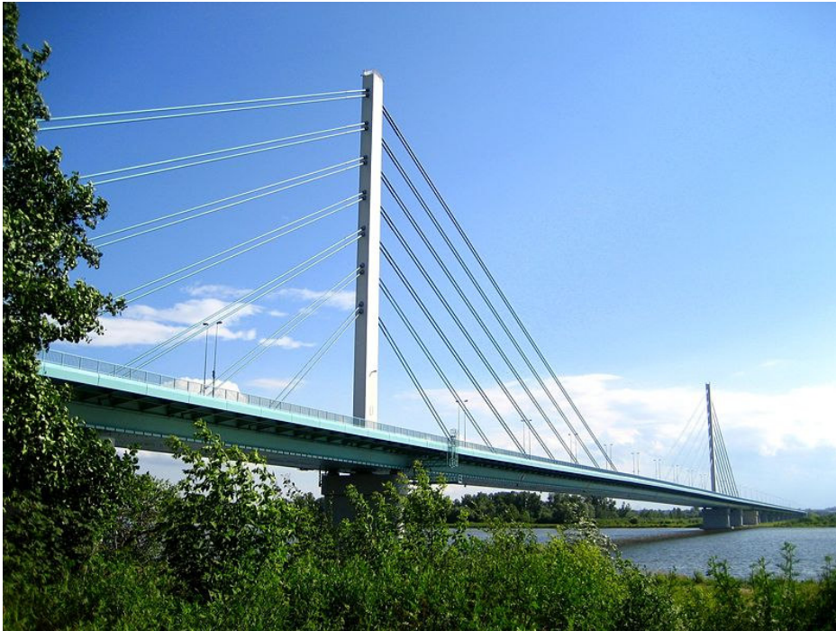
Fot. 20 Most podwieszony w poprzek doliny Wisły (Most Solidarności w Płocku). Widoczne wysokie pylony oraz cięgna stanowiące przeszkodę dla ptaków migrujących (szczególnie w nocy) (źródło: Wikipedia).
