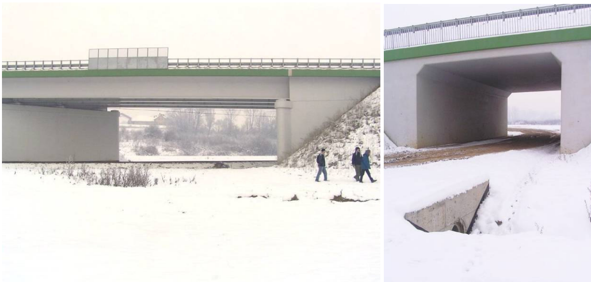
Fot.13 i 14 Wiadukty – kolejowy oraz lokalnej drogi, stanowiące dobre przejścia dla zwierząt (źródło: fotografia autora).
