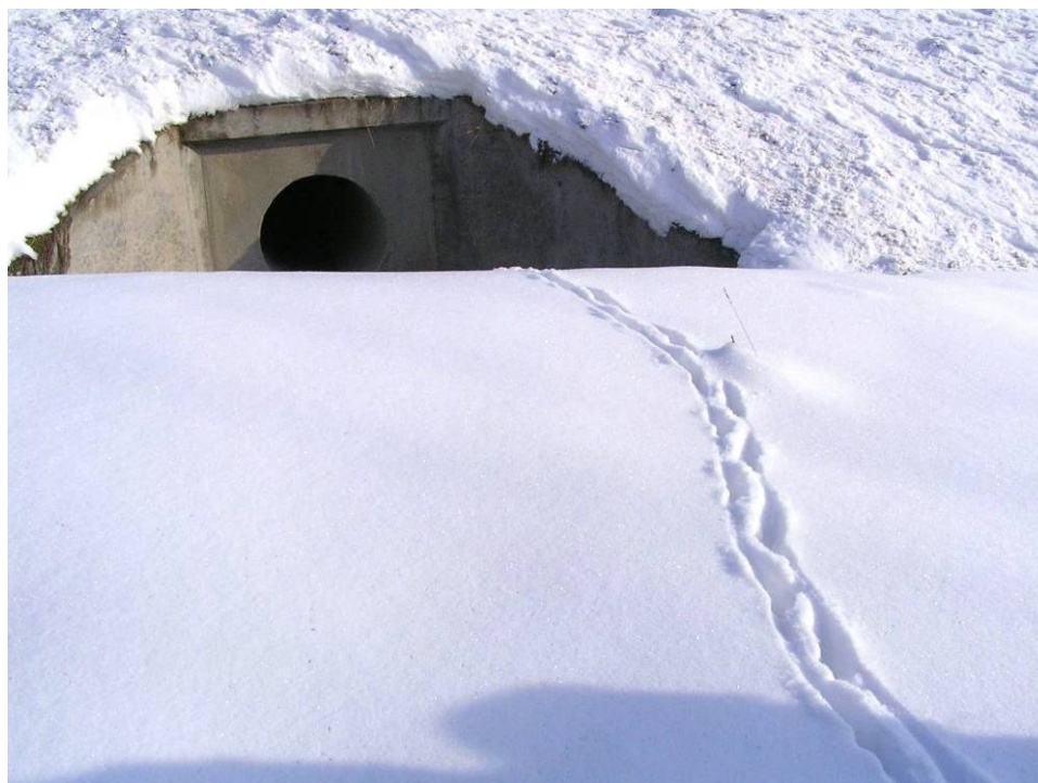
Fot. 18 Przepust pod drogą. Na śniegu widoczne tropy małego ssaka (prawdopodobnie z rodziny łasicowatych), który skorzystał z takiego przejścia (źródło: fotografia autora).
