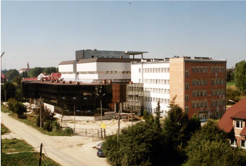
Fotografia 3 Budowa Regionalnej Biblioteki Akademickiej, wrzesień 1998 (fot. Elżbieta Wójcikiewicz)
