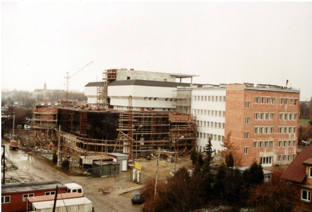
Fotografia 2 Budowa Regionalnej Biblioteki Akademickiej, czerwiec 1997 (fot. Elżbieta Wójcikiewicz)
