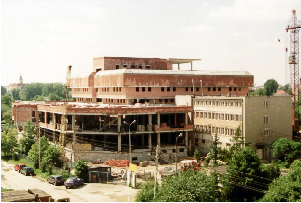
Fotografia 1 Budowa Regionalnej Biblioteki Akademickiej, kwiecień 1996 (fot. Elżbieta Wójcikiewicz)
