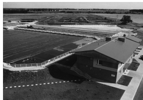
Fot. Mechaniczno-chemiczno-biologiczna oczyszczalnia ścieków w Ligocie Dolnej k/Kluczborka
