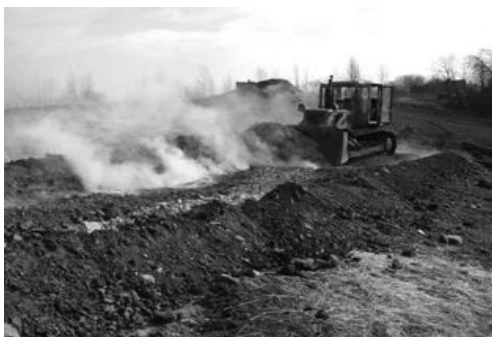
Fot. Likwidacja i ograniczenie intensywności istniejących ognisk pożarowych na terenie składowiska skały płonnej KWK Wawel
