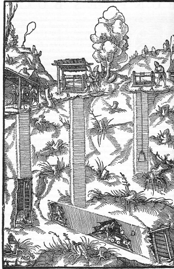
Rys. 1. Sztolnia prowadzona w kierunku szybów [1]
