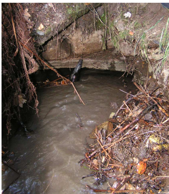
Rys. 11. Zakryty kanał odprowadzający wodę sztolniową (fot. M. Madziarz)
