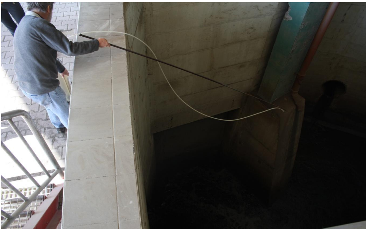
Rys. 4-10 Pobieranie próbek powietrza do oznaczeń olfaktometrycznych niebezpośrednich - komora zbiorcza we Wrocławskiej Oczyszczalni Ścieków „Janówek” (fot. wł.)
