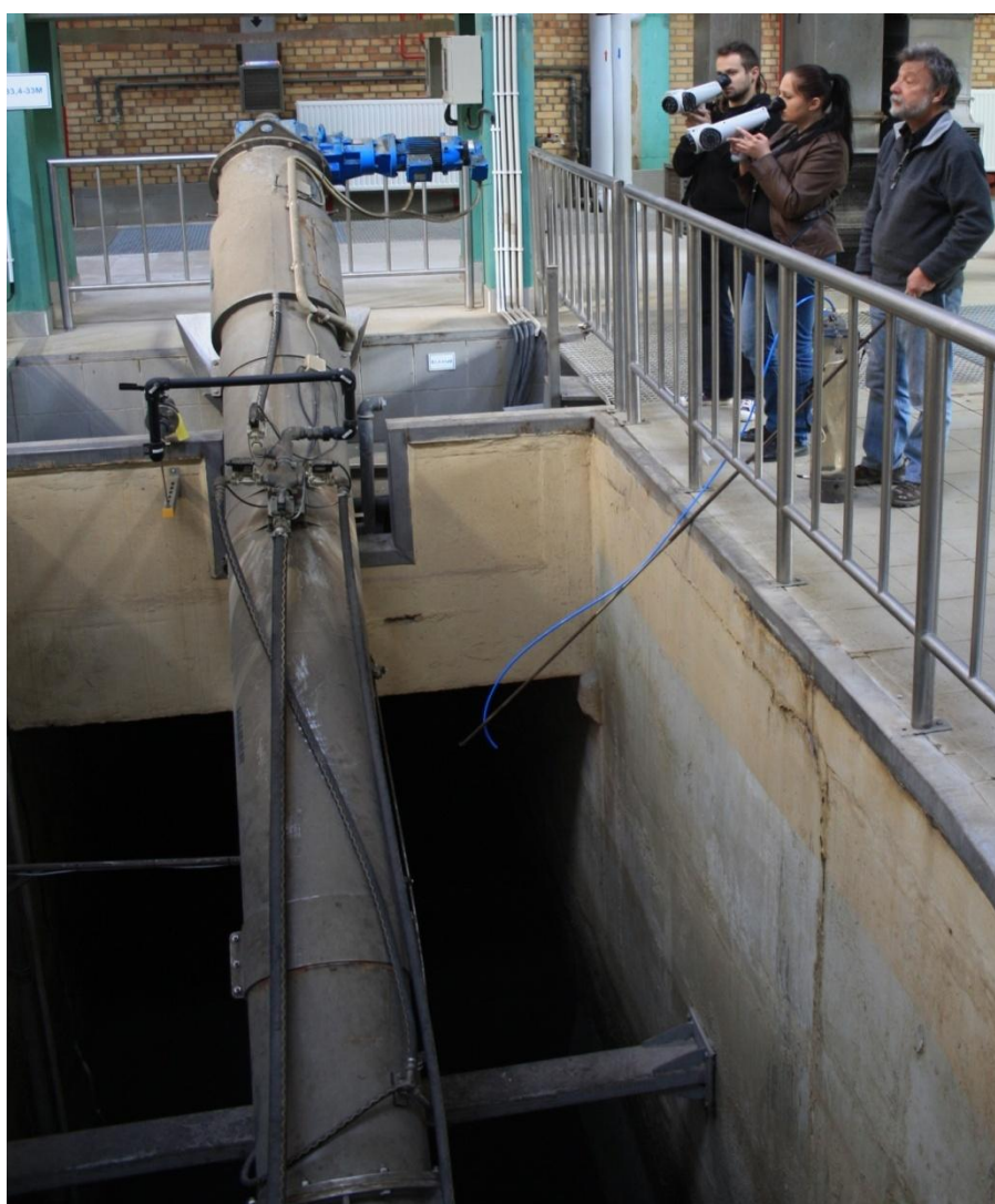
Rys. 5-6 Oznaczenie wartości D/T przy użyciu OT oraz pobieranie próbek powietrza do oznaczeń olfaktometrycznych bezpośrednich - hala krat we Wrocławskiej Oczyszczalni Ścieków „Janówek” (fot. wł.)
