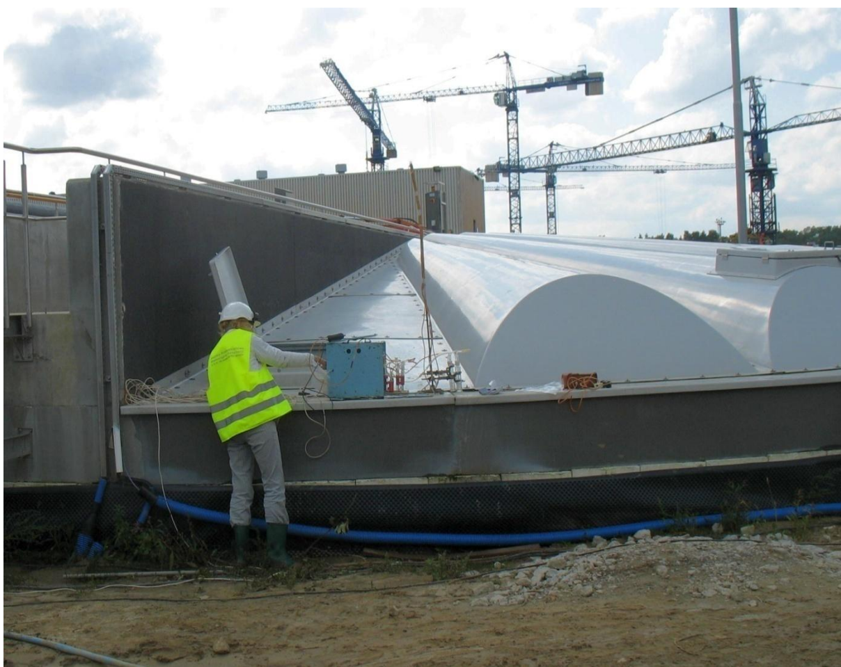
Rys. 6-13 Pobieranie próbek powietrza do oznaczeń siarkowodoru i amoniaku metodą kolorymetryczną z zagęszczacza osadu z terenu Oczyszczalni Ścieków „Czajka” (fot. wł.)
