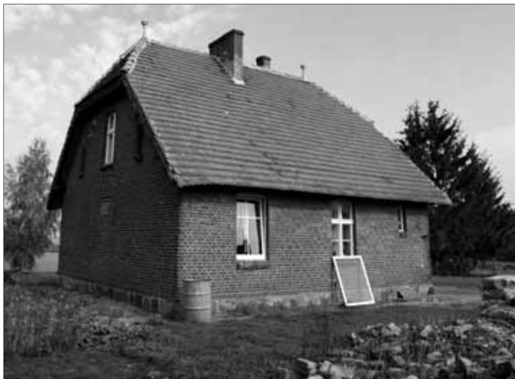
Dawny budynek policji w Doręgowicach, dom Stefana Pestki i jego rodziny. Widok od strony podwórza. Stan obecny. Archiwum Marcina Wałdocha. Fot. Andrzej Lorbiecki.
