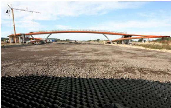
Rys. 6. Wykorzystanie kruszyw alternatywnych: A) z żużli pohutniczych do budowy autostrady A4(11), B) z żużli paleniskowych do budowy nasypu pod lokalizację hali (19)
