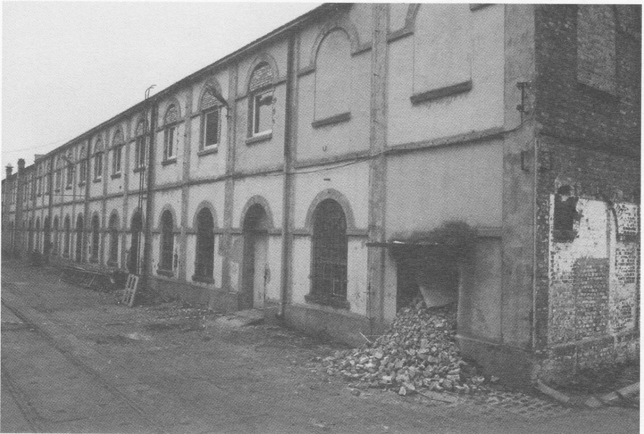
Początek remontu budynku przędzalni (źródło: Archiwum Firmy Sokpol)
