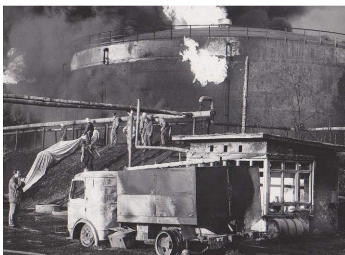
Ryc. 8. Zniszczenia spowodowane wyrzutem płonącej ropy ze zbiornika Źródło: Centralne Muzeum Pożarnictwa w Mysłowicach.
