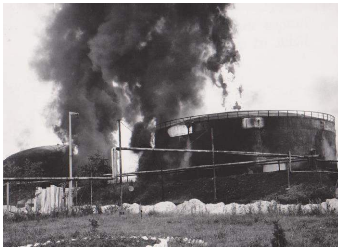
Ryc. 7. Uszkodzone w wyniku pożaru zbiorniki – pożar w rafinerii ropy Czechowice-Dziedzice Źródło: Centralne Muzeum Pożarnictwa w Mysłowicach.
