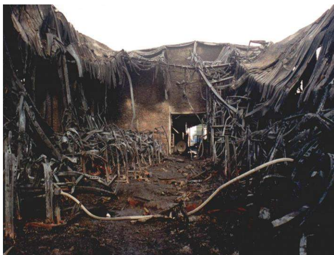
Ryc. 51. Zniszczona pożarem hala zakładu POLARCUP Źródło: Archiwum KW PSP Katowice.
