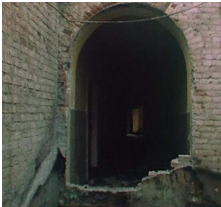
Ryc. 15. Widok pozostałości ścianki, którą zamurowano drzwi
