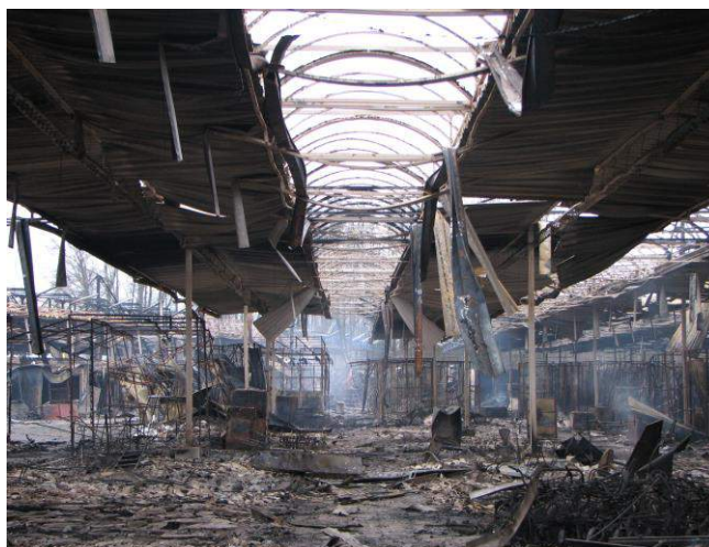
Ryc. 63. Widok zniszczonych stanowisk kupieckich
