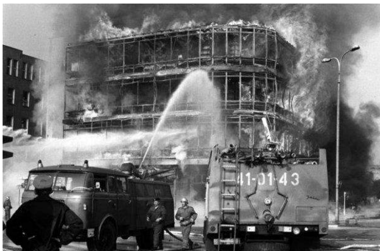
Ryc. 25. Działania gaśnicze podczas gaszenia pożaru Kaskady Źródło: Marek Czasnojęc – archiwum KW PSP Szczecin.
