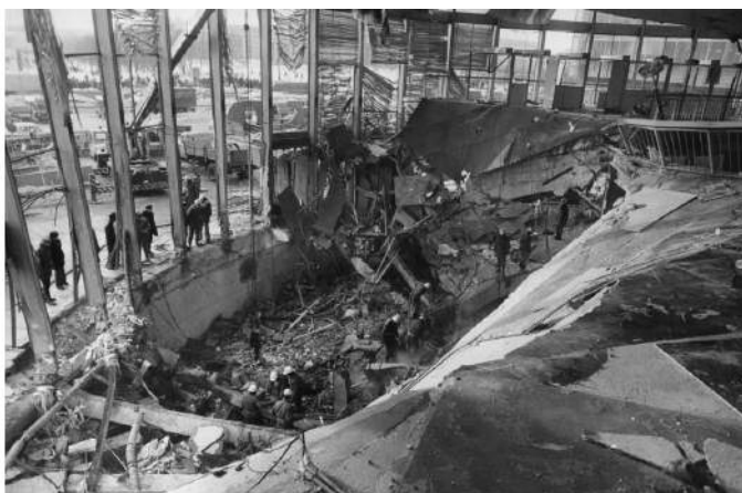
Ryc. 11. Widok zniszczeń we wnętrzu Rotundy PKO
