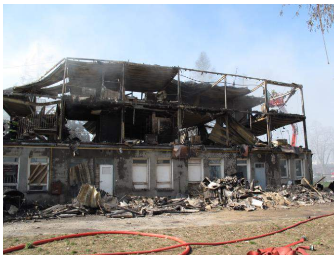
Ryc. 70. Widok zniszczeń spowodowanych pożarem Źródło: Analiza KG PSP – archiwum KG PSP.
