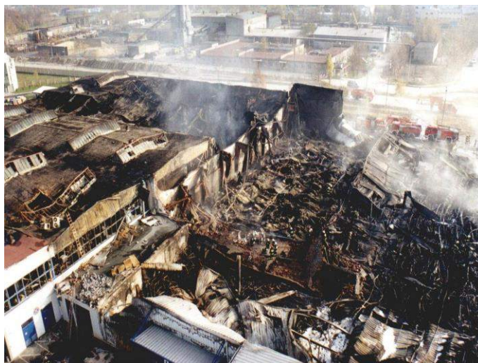
Ryc. 52. Widok zniszczeń spowodowanych pożarem w zakładzie POLARCUP Źródło: Archiwum KW PSP Katowice.
