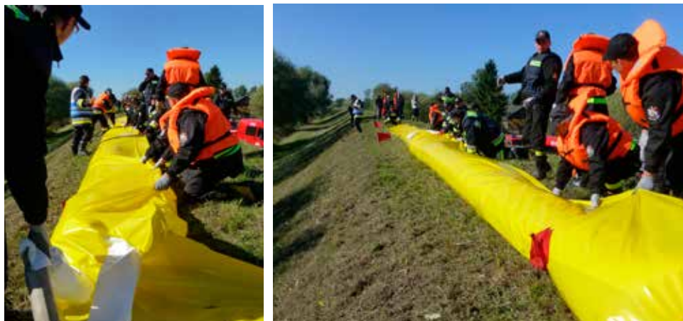
Ryc. 4. Staczanie się rękawa podczas nieprawidłowo prowadzonego procesu sprawiania Źródło: Wyk. D. Riegert.
