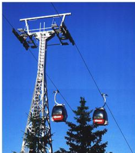
Rys. 7 Widok kabin i podpory
