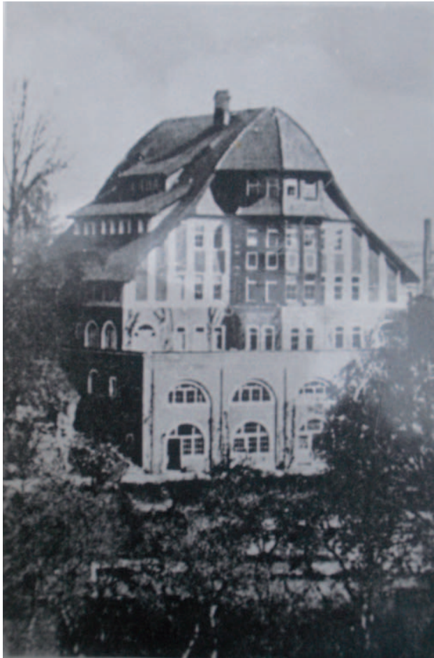
Schronisko Boberhaus w Lwówku Śląskim. Stan sprzed 1945 r. Archiwum S. Fikusa
