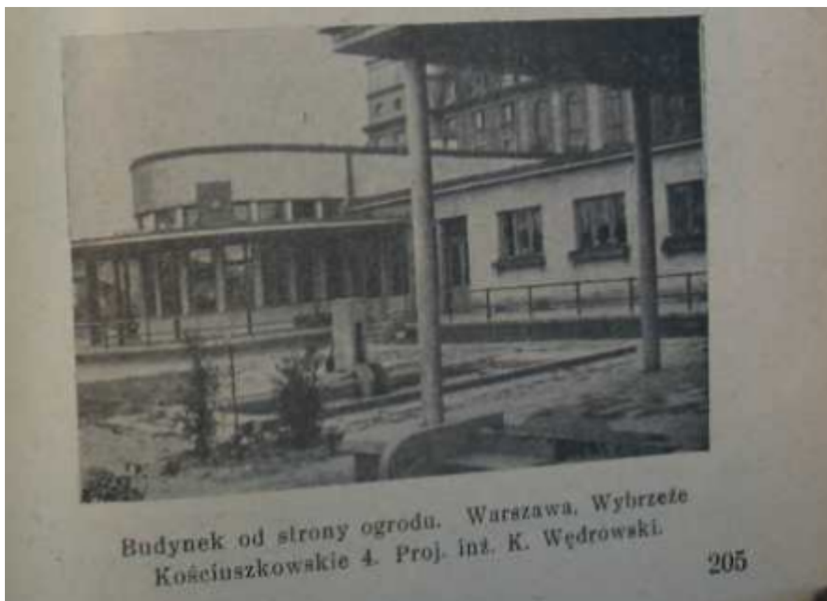
Ilustracja 4.2: Budynek przy ogrodzie jordanowskim na Powiślu. ilustracja z książki Ogrody jordanowskie
