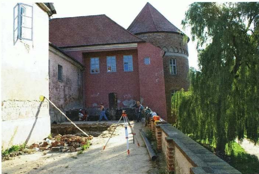
Widok ściany zachodniej skrzydła wschodniego oraz międzymurza w początkowej fazie badań (fot. R. Herman).
