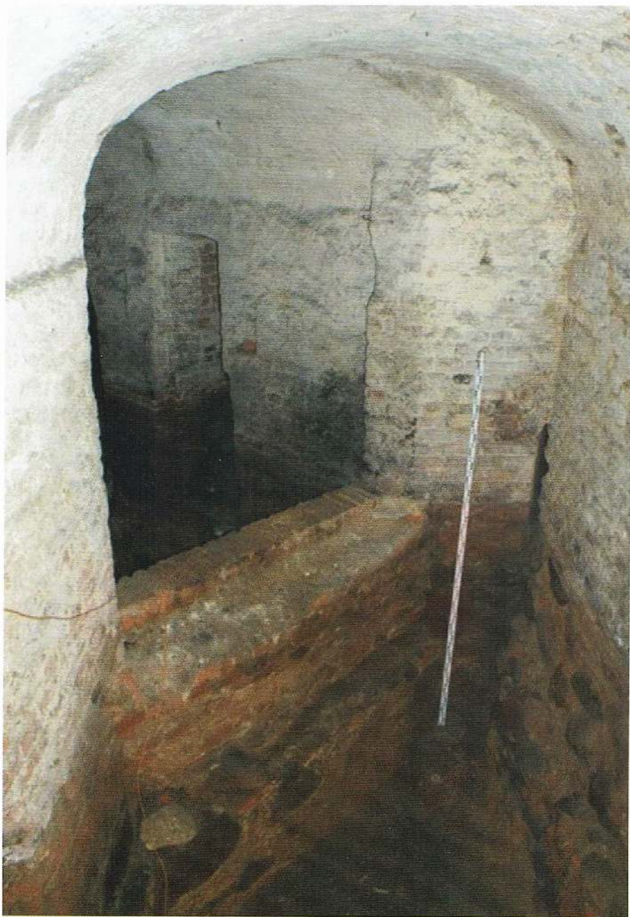
Pierwsze wejście do przyziemia baszty. Widoczna odsadka w dolnych partiach murów wyznacza poziom użytkowy przyziemia baszty. W głębi widoczny wylot klatki schodowej (fot. R. Herman).
