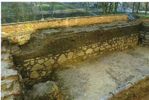
Zewnętrzny mur obronny ze strzelnicą w zachodniej części międzymurza (fot. R. Herman).
