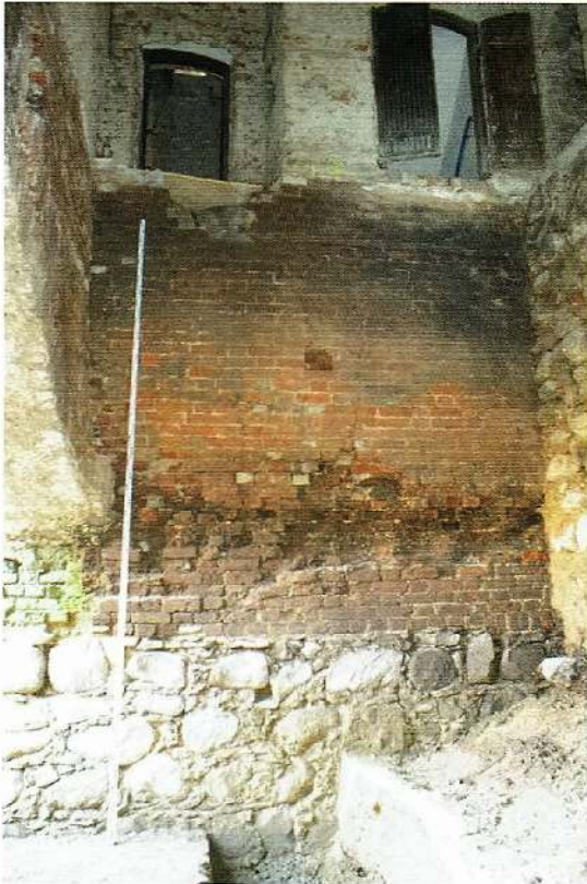
Pierwotna ściana szczytowa skrzydła wschodniego. (fot. R. Herman).
