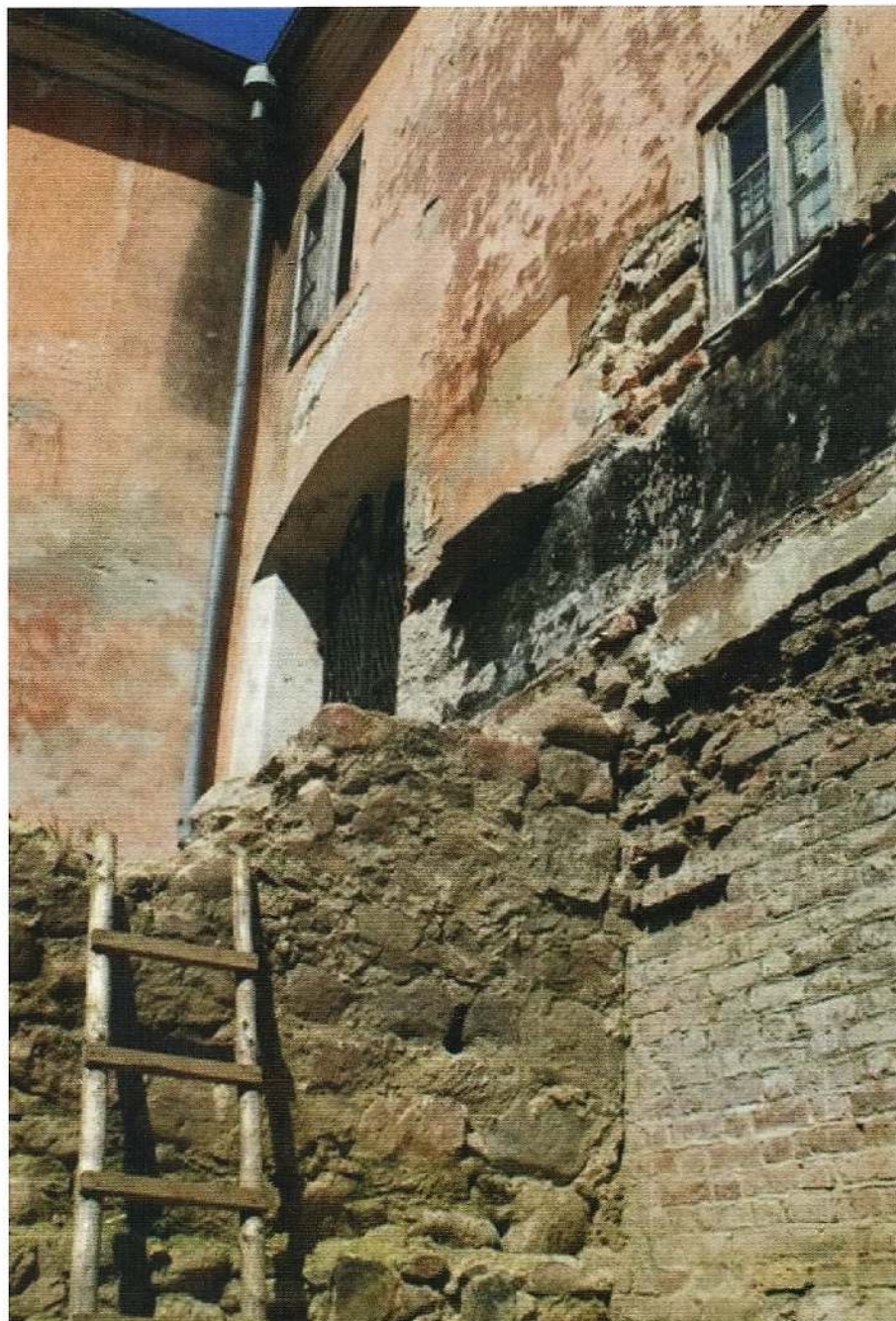
Strzypia w południowej elewacji muru obronnego (fot. R. Herman).
