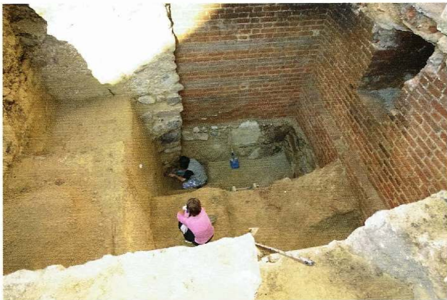
Styk wschodniej ściany wieży (pokryta dekoracją malarską) i muru obronnego w rejonie wjazdu (w murze otwór „wodociagowy”). Do wieży dostawiona kamienna ściana przedbramia. Badania sondazowe (fot. R Herman).
