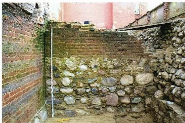
Styk południowej ściany wieży (po lewej - z dekoracją malarską) i zachodniej ściany przedzamecza (fot. R. Herman).
