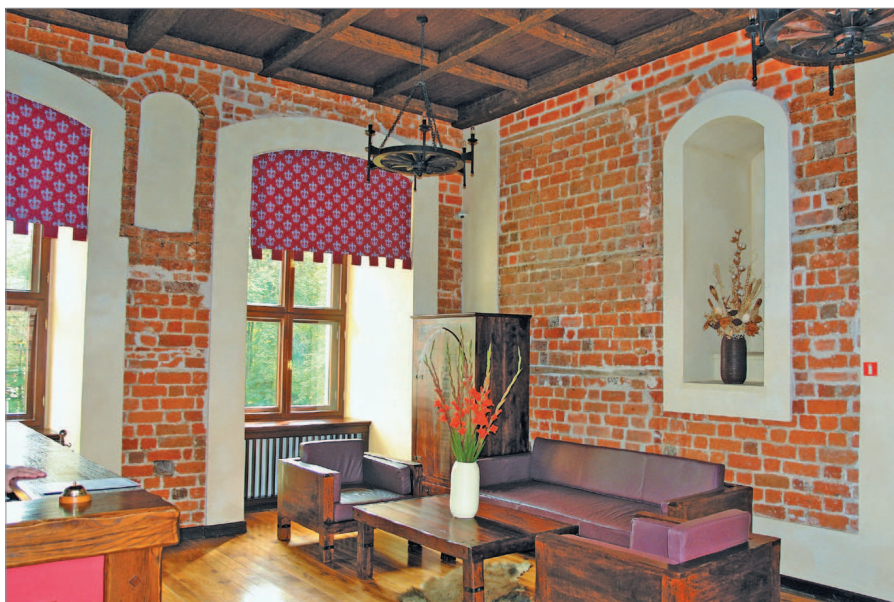
Il. 21. Pomieszczenie nad bramą w zamku uniejowskim w 2014 r. Odslonięte lica ceglane pomieszczenia z wmurowanymi listwami podtrzymującymi tapiserie (fot. R. Herman).
