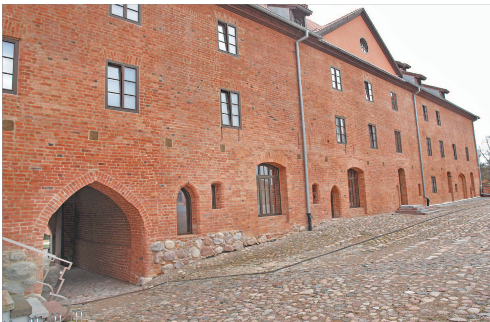
Il. 16. Skrzydło zachodnie przedzamcza w Lidzbarku Warmińskim, widok od strony dziedzińca. Na piętrze widoczne osadzone w gniazdach strzępia belek podtrzymujących ganek komunikacyjny. Fotografia z 2014 r. (fot. R. Herman).
