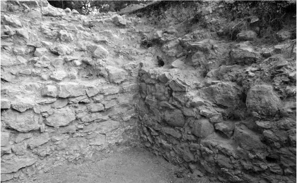
Ryc. 6. Odslonięty narożnik w ruinie tzw. Domu Kasztelanowej. Widok od południowego-zachodu (fot. W. Dudak)
