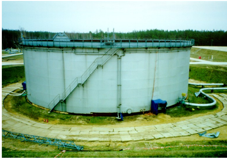
Rys. 2. Widok ogólny zbiornika
