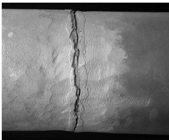
Rys. 5. Widok pękniętego złącza spawanego
