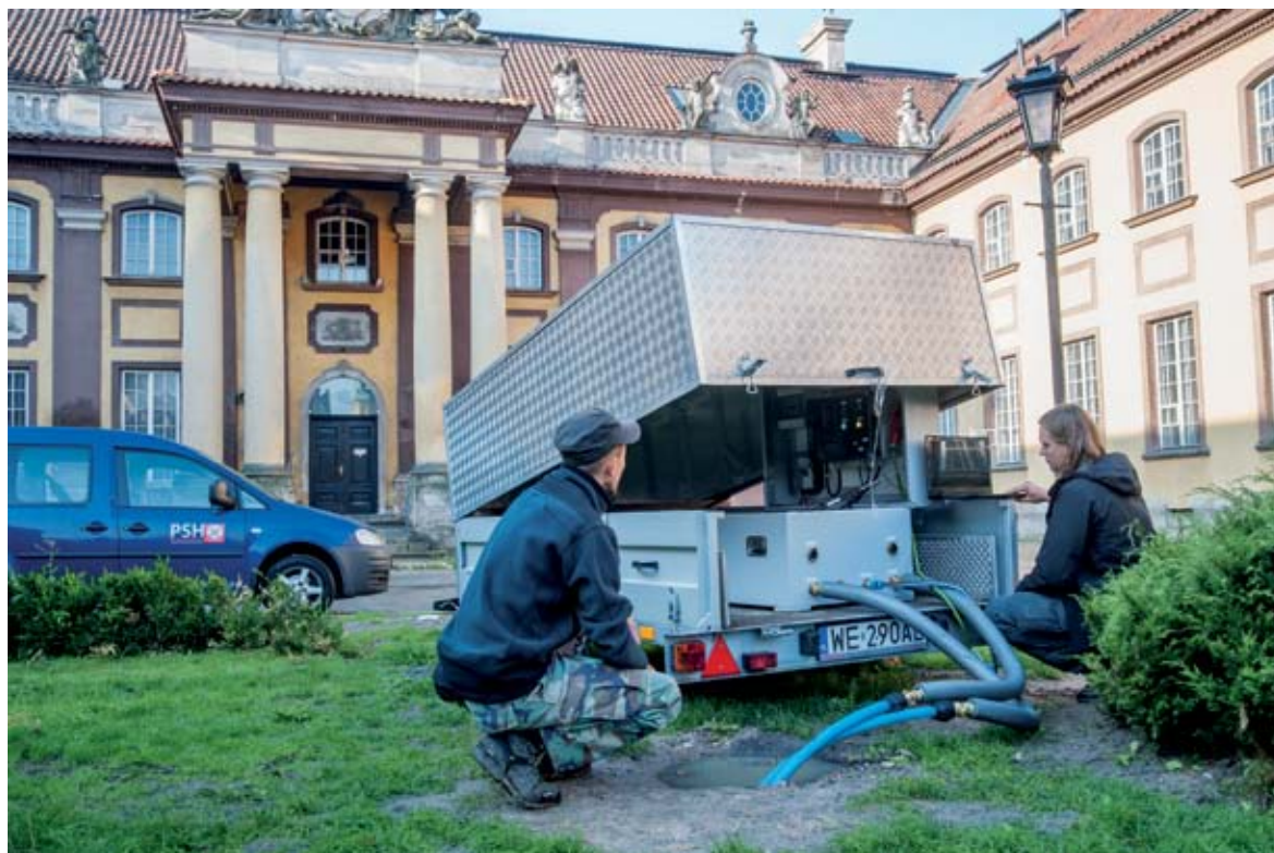
Rys. 37. Test reakcji termicznej (TRT). Fot. M. Szlasa
