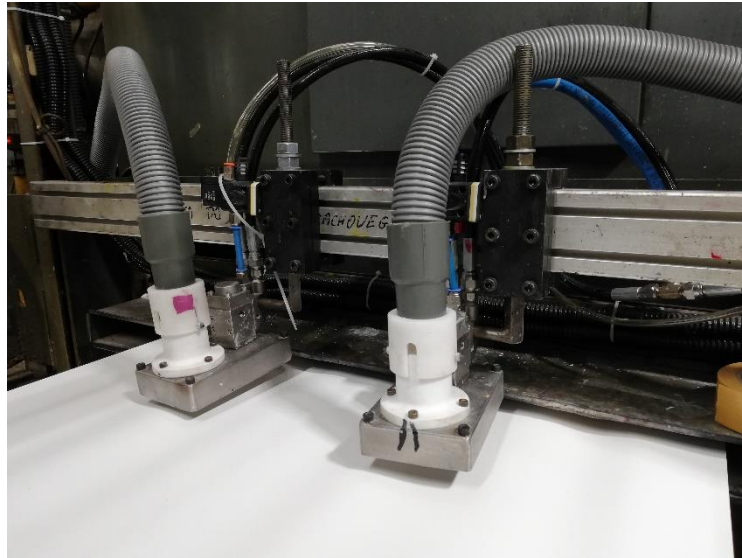
Rys.1. System odciągu mgiełki lakieru – rury odciągowe i kołnierze osłonowe pistoletów natryskowych
