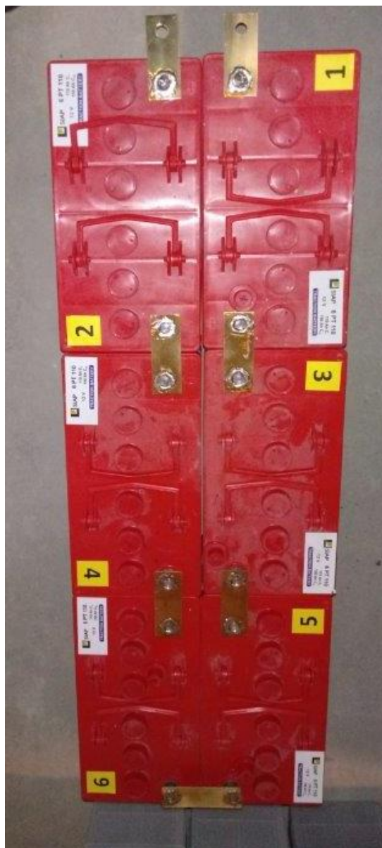
Zdjęcie 11. Połączenie akumulatorów ołowiowych z elektrolitem ciekłym poprzez lutowanie
