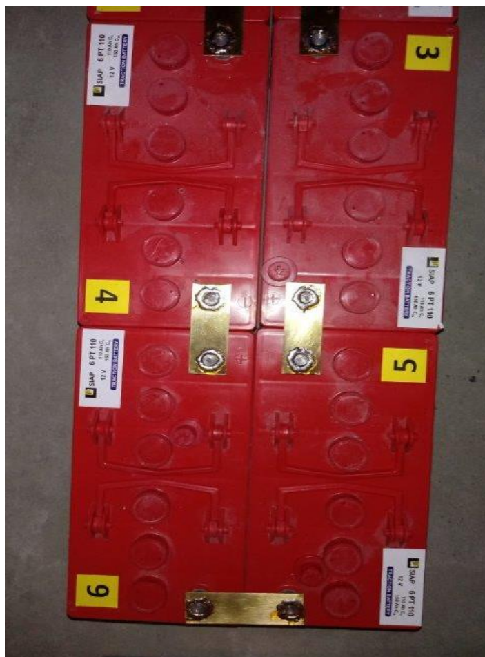
Zdjęcie 12. Połączenie konektorów poprzez lutowanie
