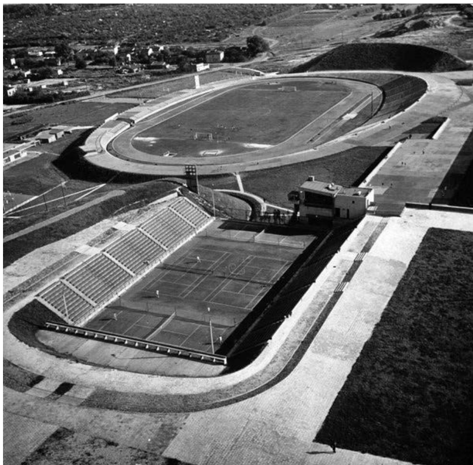
Fot. 1. Stadion Warszawianki Źródło: „Architektura”, 1967, 5/6: 225.
