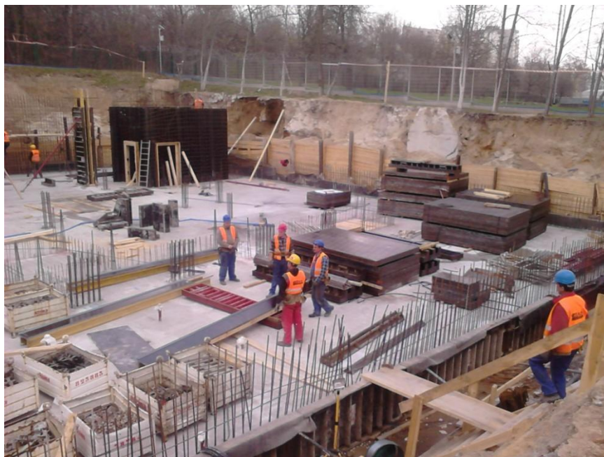
Fot.2. Składowanie materiałów na terenie obiektu [7]
