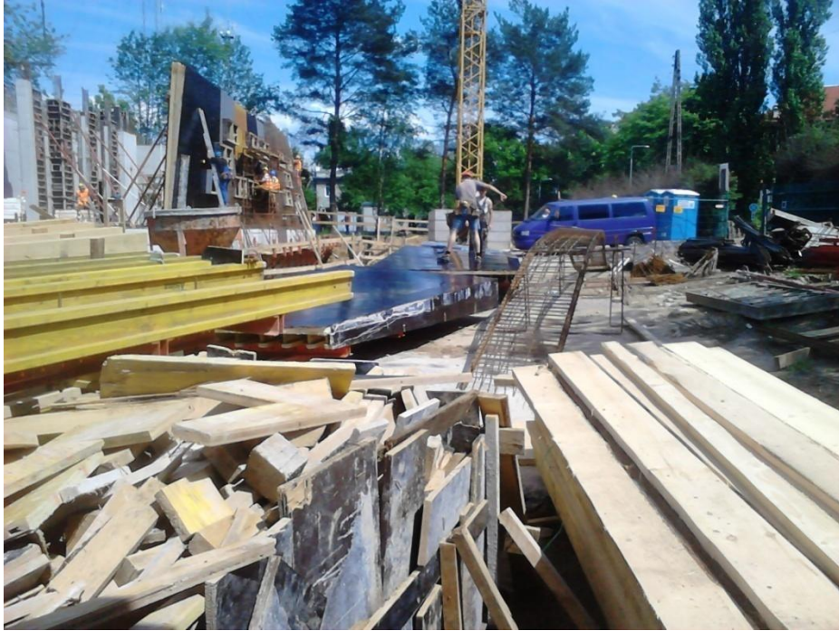
Fot.3. Wykorzystanie drogi wewnętrznej w warunkach ograniczonego placu budowy
