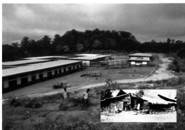
FOT. 5. Widok szpitala z roku 1983
