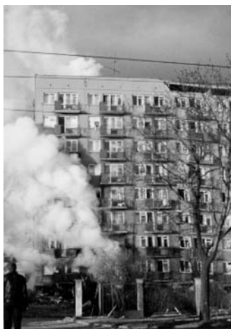
Fot. 2. Zdjęcie wieżowca przed wysadzeniem (Fot. KWSPS-Gdańsk)
