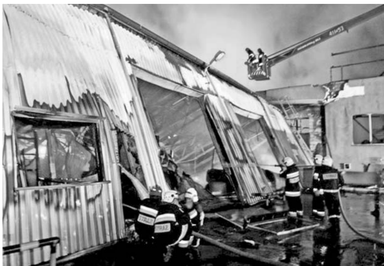
Fot. 1. Płonące budynki zakładu Quickpack Polska
