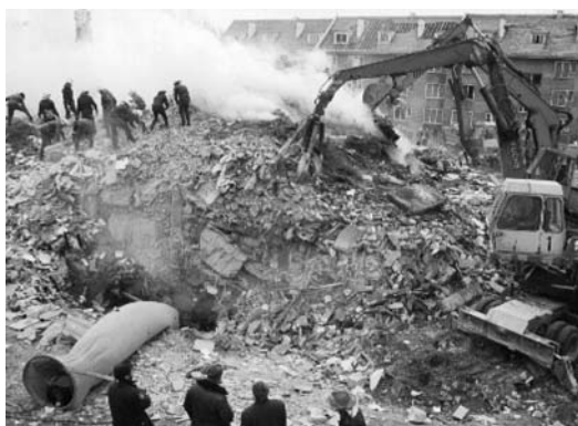
Fot. 3. Po wyburzeniu budynku (Fot. KWSPS-Gdańsk)
