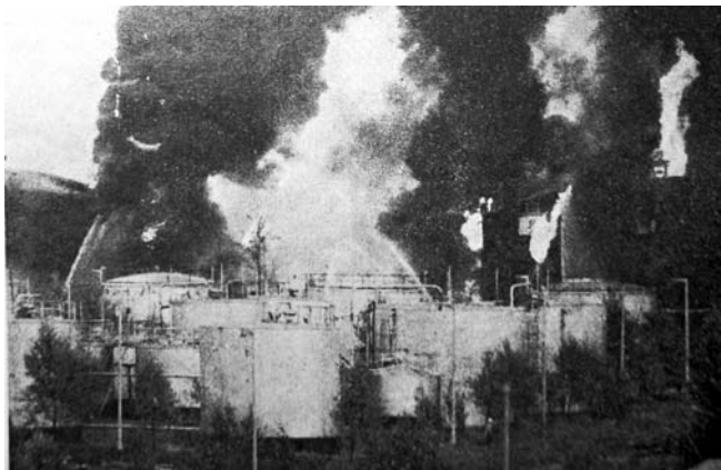
Fot. 1 - Zagrożenie pożarowe wynikające z usytuowania zbiorników z ABT
